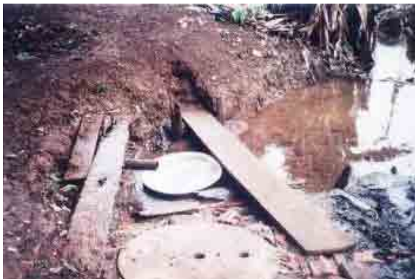
Figura 1 – Tipo de captação de água de mina
