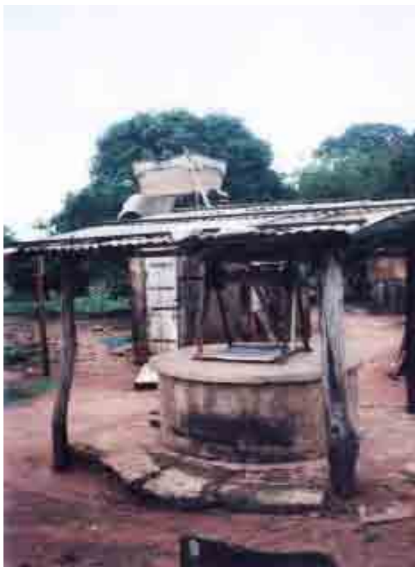
Figura 5 – Localização de poço próximo à fossa
