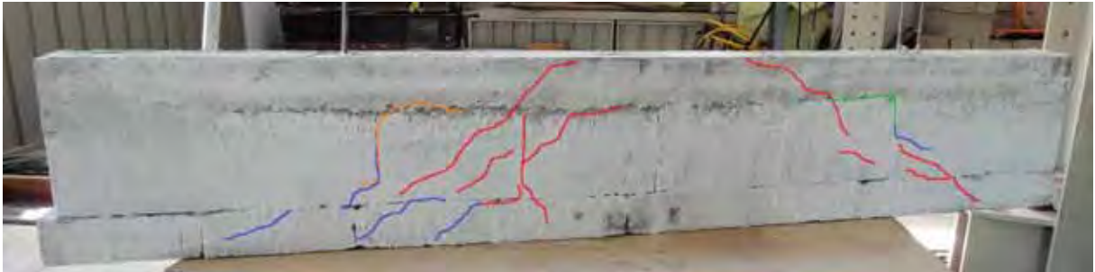
Figura 39- Fissuras – Viga 1 – VIDupla
