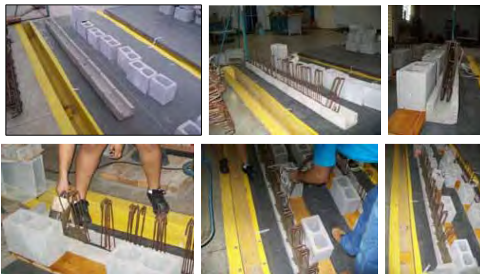
Figura 9 - Etapas da execução da primeira fiada
