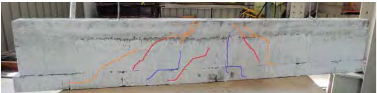
Figura 40 - Fissuras – Viga 2 – VIDupla
