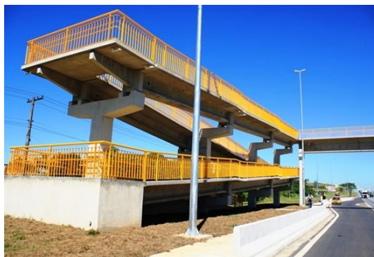
Figura 28 – Exemplo de passarela sobre a via Dutra
