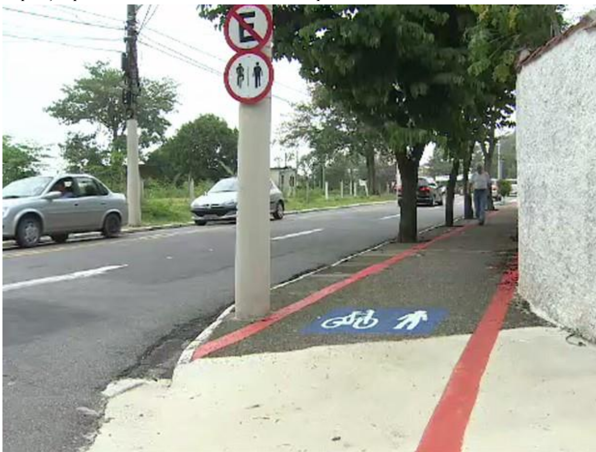
Figura 12 – Um híbrido de calçada e ciclovia em uma rua de São José dos Campos, cuja disposição pode causar acidentes entre ciclistas e pedestres
