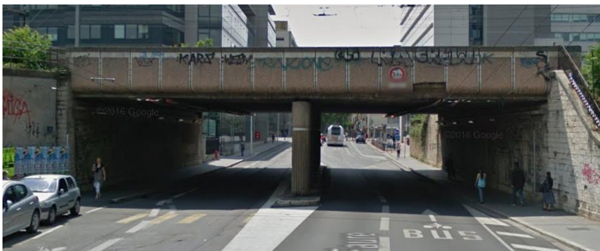
Figura 30 – Passagem sob ferrovia em uma rua de Lyon.
