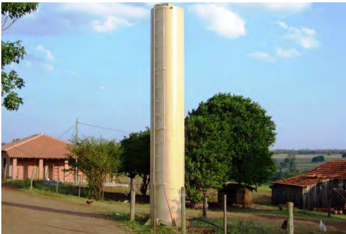
Foto 15 - Poço semi-artesiano construído pelo PEMH na microbacia da água das Antas/Pinheiro.
