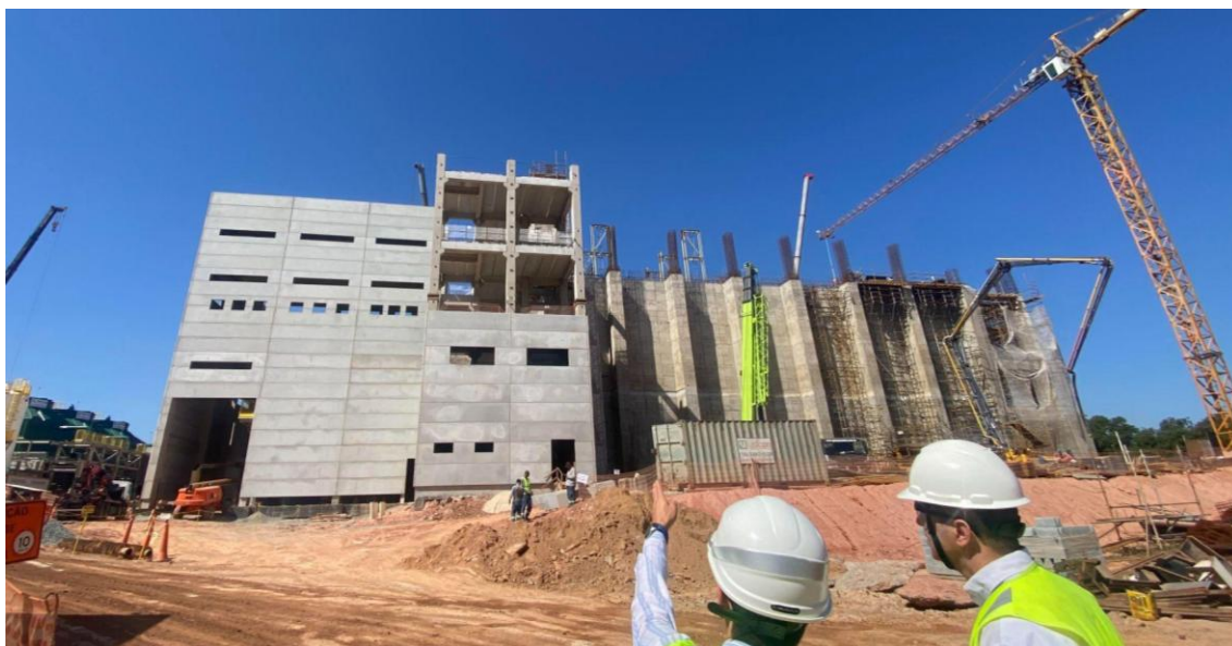
Figura 6 – Obras da URE Barueri durante visita técnica realizada em 2026.
