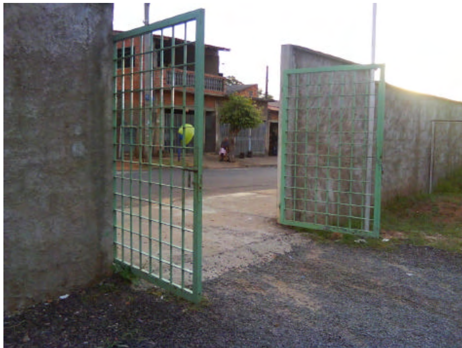
Figure 11: Portão do Estacionamento da Escola.
