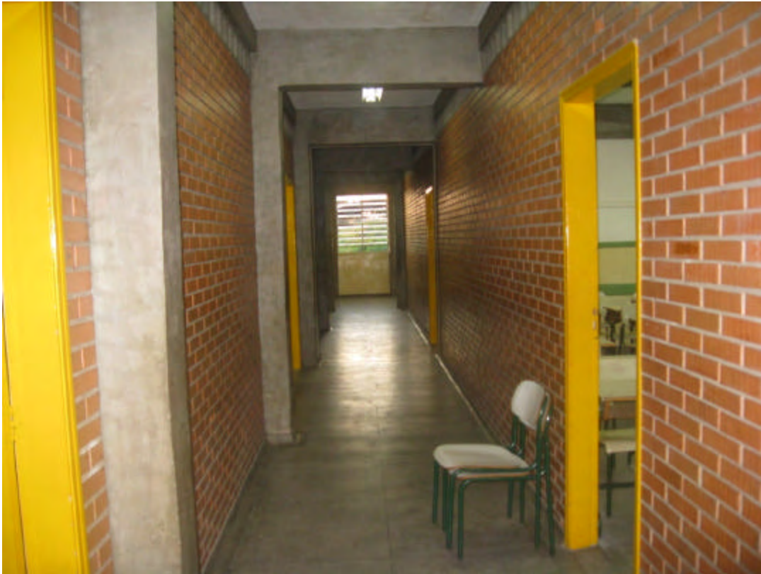
Figure 14: Corredor de acesso às salas de aula.
