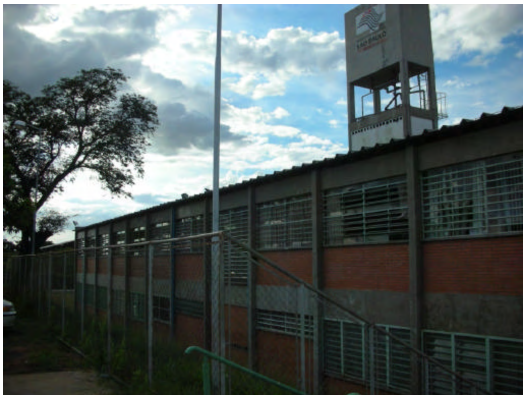
Figure 6: Vista externa do edifício da Escola Estadual Profº Marivaldo Carlos Degan.
