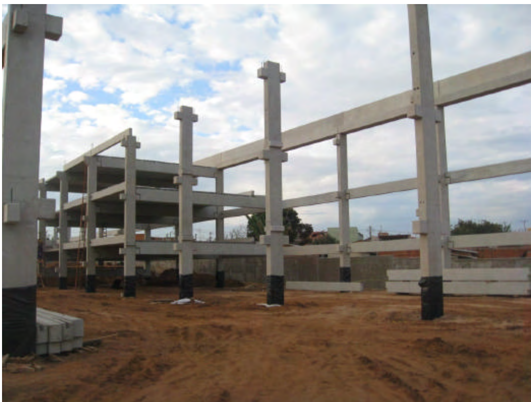
Figure 15: Estrutura pré-moldada da futura escola sendo finalizada.
