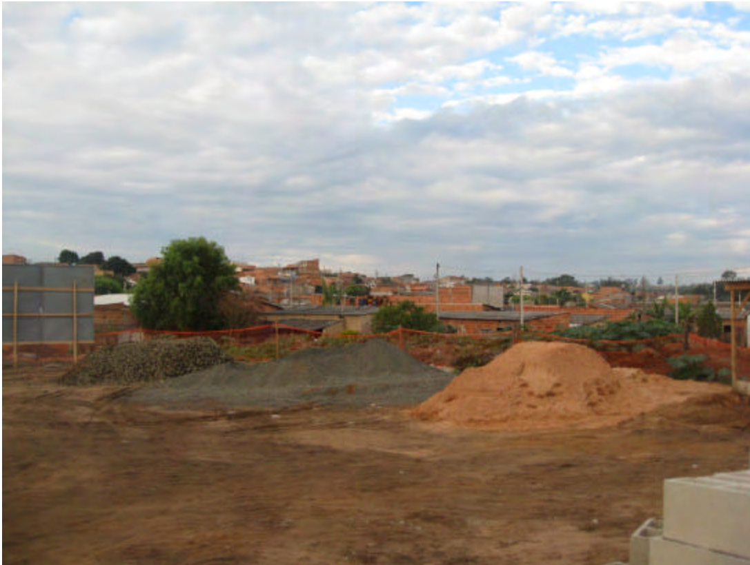
Figure 16: Vista de dentro da obra da futura escola para as casas do outro lado da implantação.
