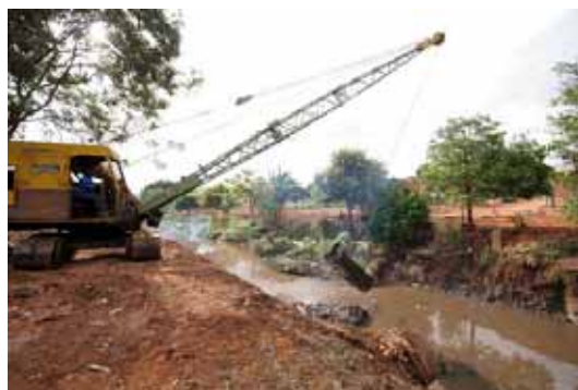
Figura 29: Desassoreamento do Córrego do Tanquinho Fonte: Prefeitura de Ribeirão Preto (2011)
