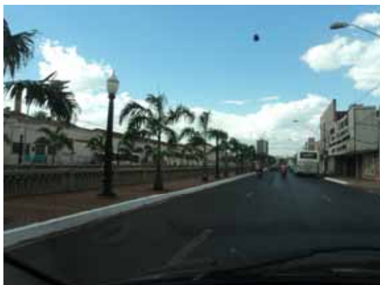
Figura 21: Revitalização das margens do Ribeirão Preto após obras antiinche, na Avenida Jerônimo Gonçalves Foto da Autora (março de 2012)
