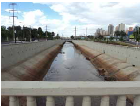
Figura 19: Córrego Ribeirão Preto após obras antiinche, na Avenida Jerônimo Gonçalves Foto da Autora (março de 2012)
