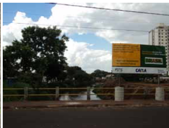
Figura 16: Obras no Ribeirão Preto Foto da autora (março de 2012)
