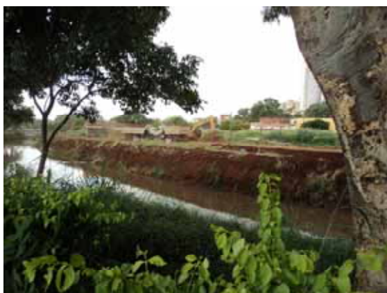
Figura 15: Início das obras antiinche em Ribeirão Preto, na Avenida Álvaro de Lima Foto da autora (março de 2012)
