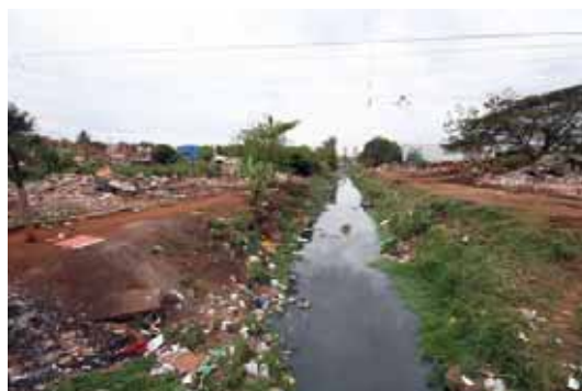
Figura 27: Lixo retirado da APP do Córrego do Tanquinho Fonte: Prefeitura de Ribeirão Preto (2011)
