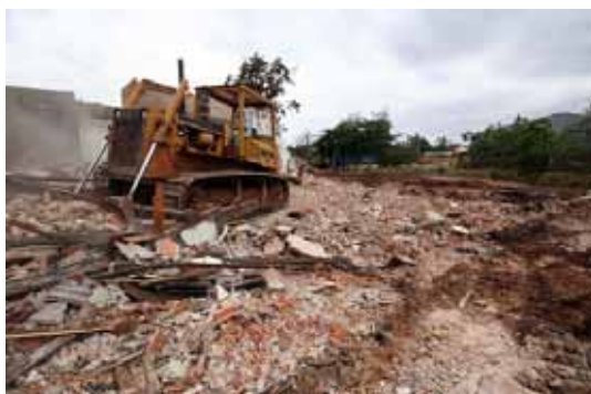
Figura 26: Demolição da favela do Tanquinho Fonte: Prefeitura de Ribeirão Preto (2011)
