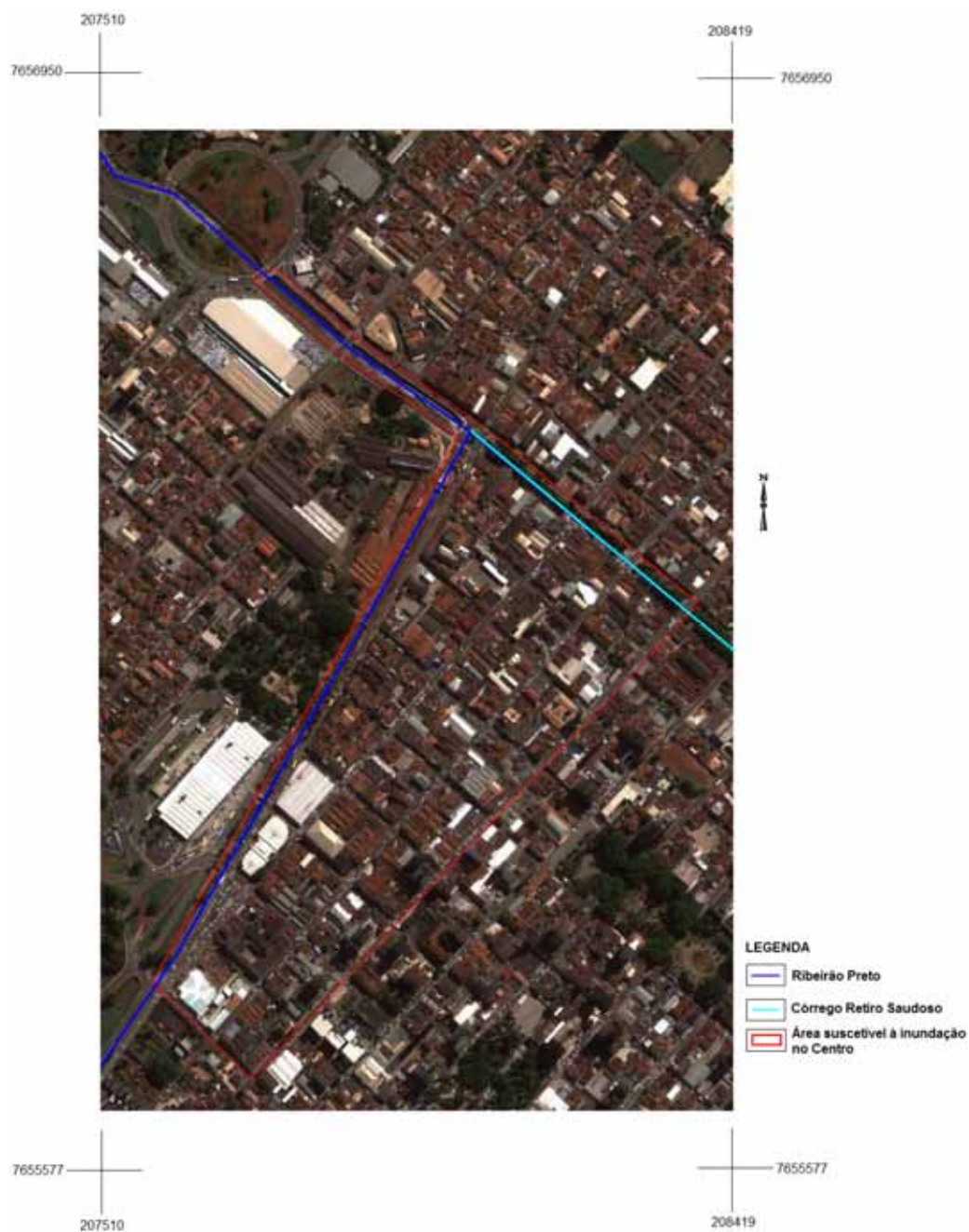
Figura 10: Uso e ocupação do Solo nas áreas mais suscetíveis a inundações e alagamentos na área Central
