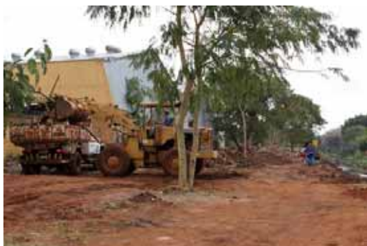
Figura 28: Limpeza da área após desfavelamento Fonte: Prefeitura de Ribeirão Preto (2011)
