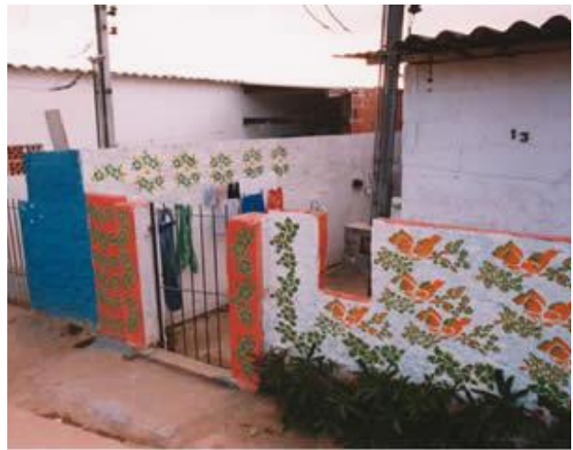
Figura 47 - Fachada de casa do Jardim Miriam
