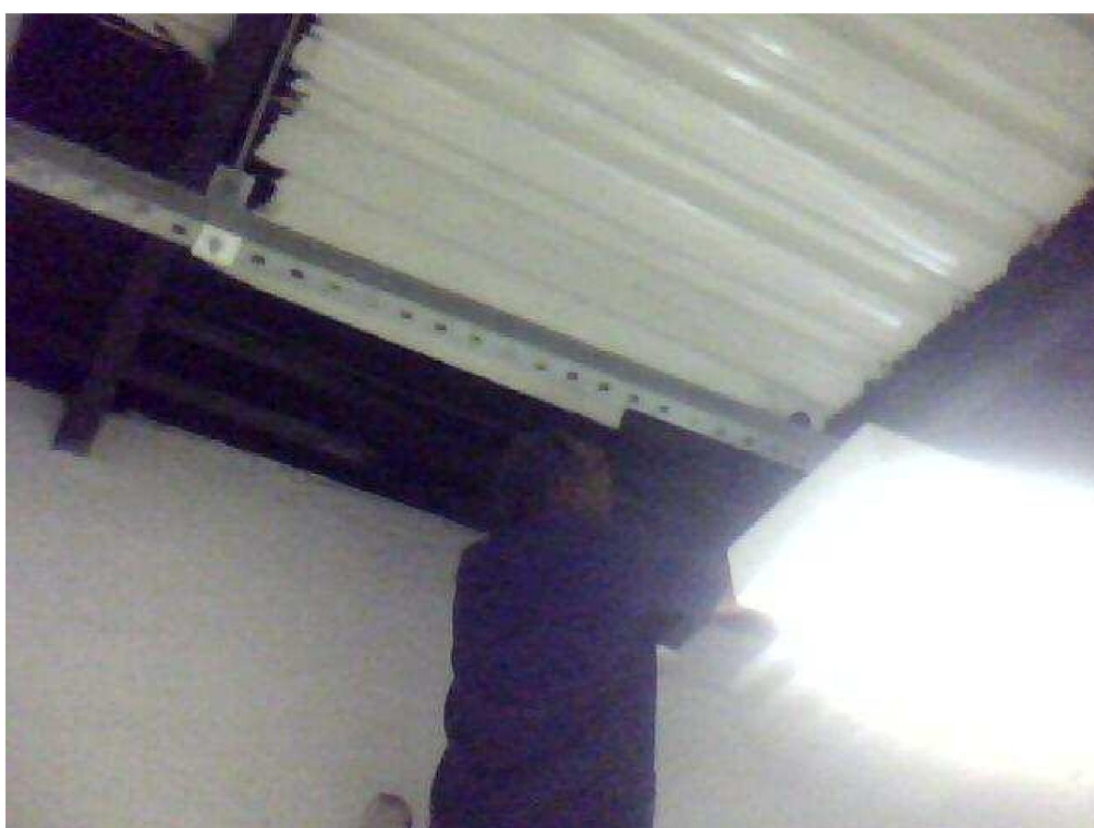
Figura 15 - Pintor executando a pintura de paredes e teto
