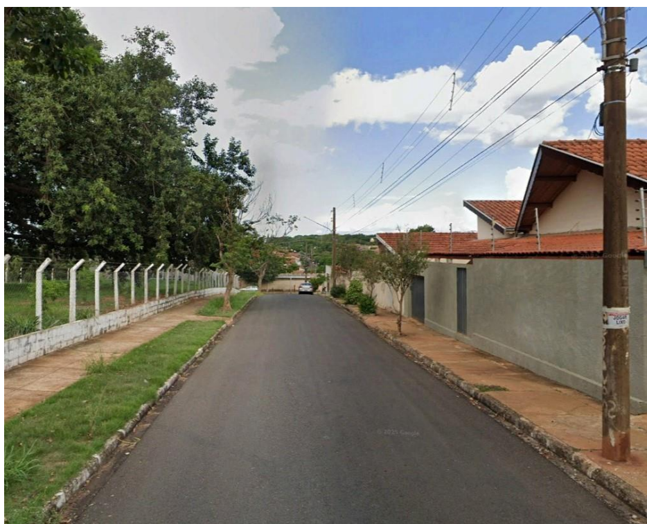
Figura 11 – Trecho 1, Rua Monção
