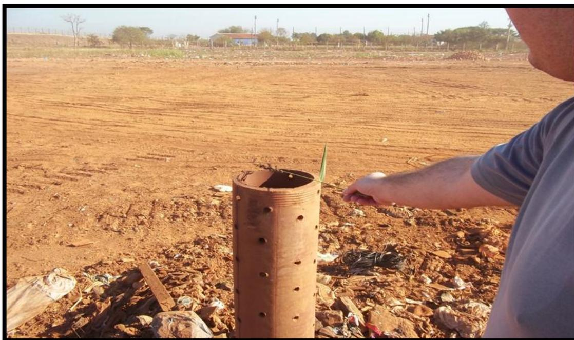
Figura 2: Canalização e queima dos gases formados em ambiente anaeróbico no aterro controlado de Ourinhos/SP. Foto: Coletti (2011).
