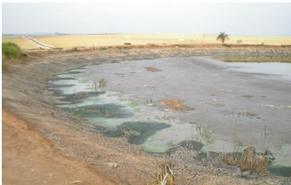
Figura 3 - Lagoa de decantação de água de manipueira, em Santa Maria da Serra.
