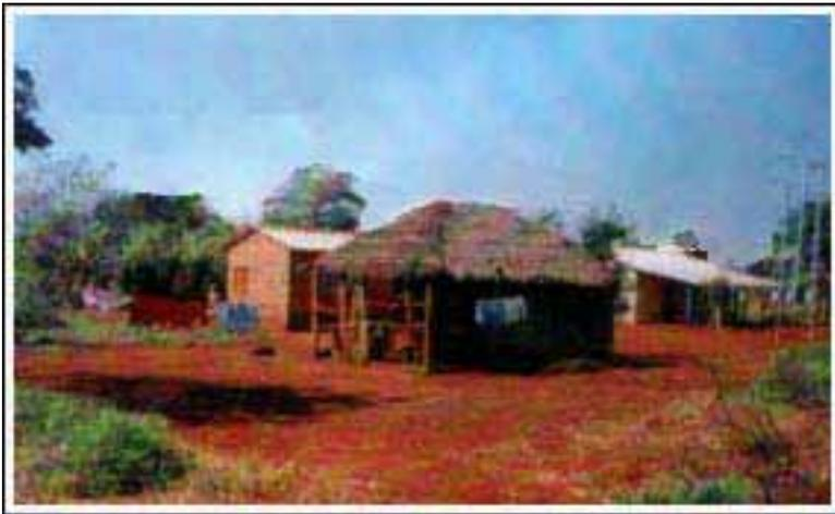
**Figura 26- Registro da substituição da cobertura de capim sapé por cimento amianto nas moradias das reservas indígenas no estado de Mato Grosso do Sul. Fonte: Parra (2001)**
