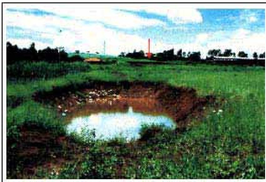
**Figura 99- "Piscinão" construído na área do lixão de Serrana para captação das águas pluviais. Ao fundo, a área de deposição de lixo. Fonte: Santos (2004)**
