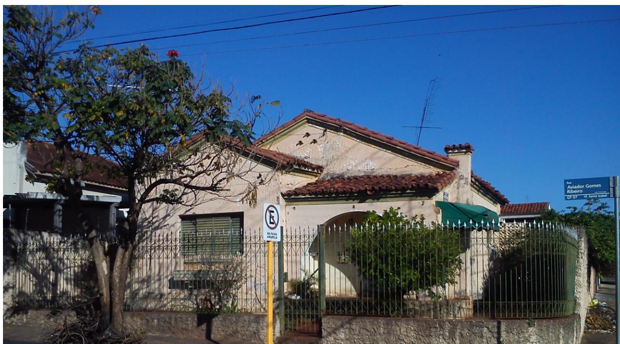
Figura 72 – Vila Santa Izabel, bangalô localizado na esquina das Ruas Alfredo Ruiz e Aviador Gomes Ribeiro.
