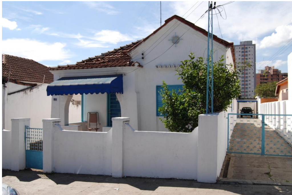
Figura 65 – Bangalôs com varanda “boca de forno”, localizados à Rua Antônio Alves e à Rua Aviador Gomes Ribeiro.
