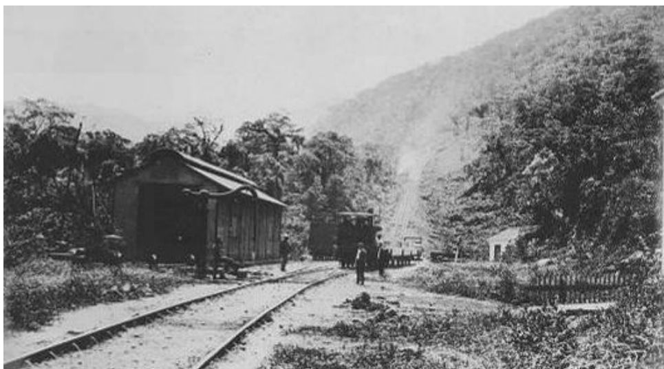
Figura 11 – Construção da São Paulo Railway
