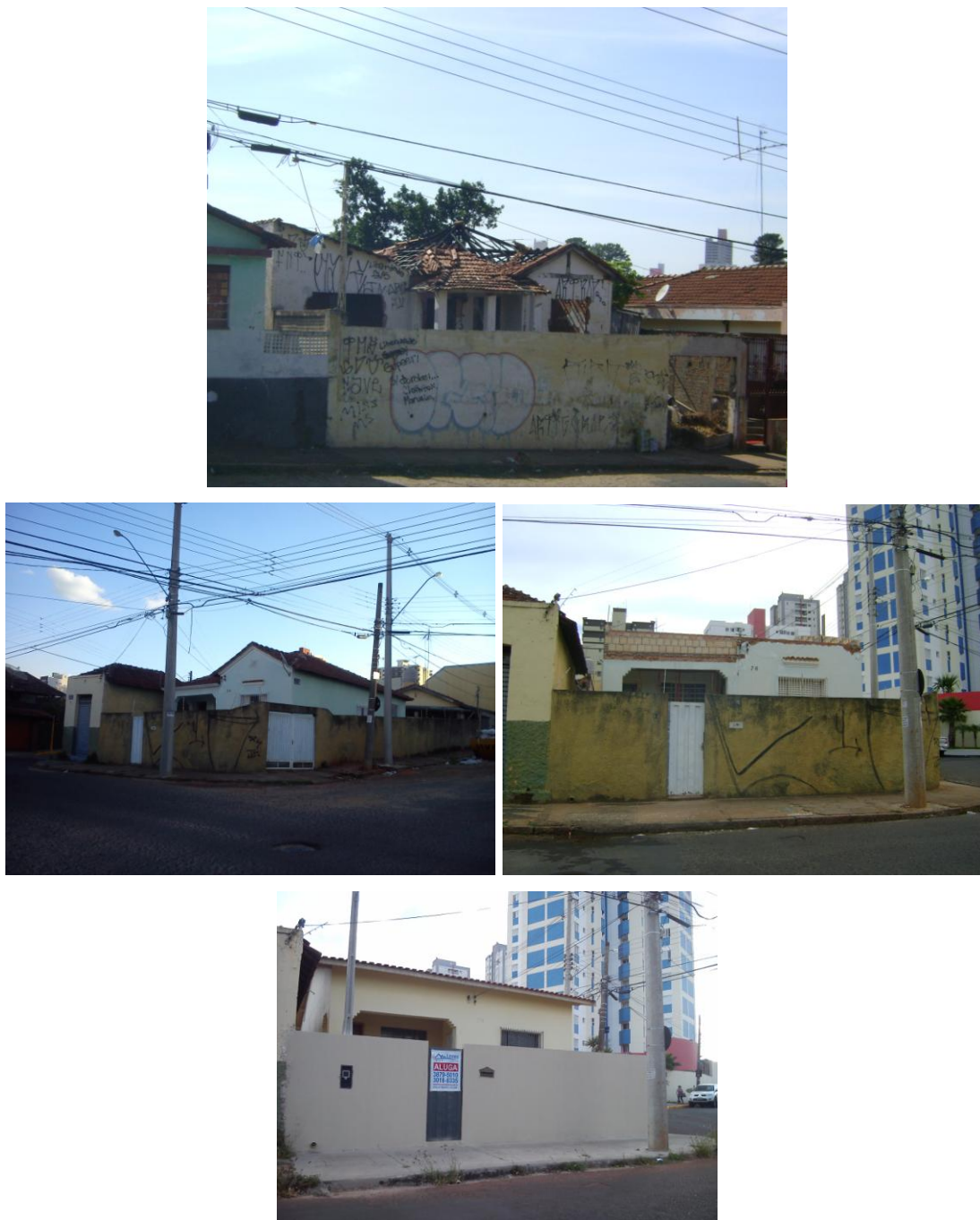
Figura 86: Bangalô deteriorado, Vila Falcão; bangalô descaracterizado, Rua Padre João.
