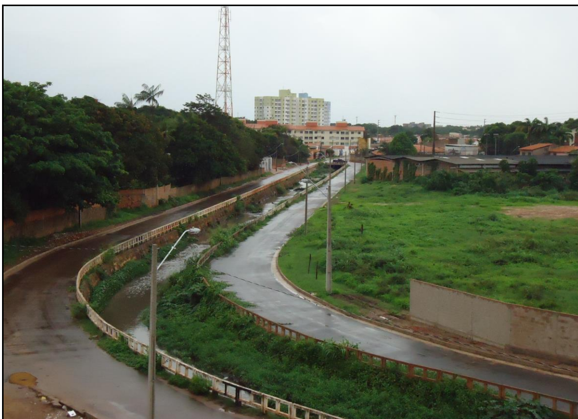
Figura 90: Trecho do Rio Turu canalizado e ruas construídas onde antes ficavam as margens.
