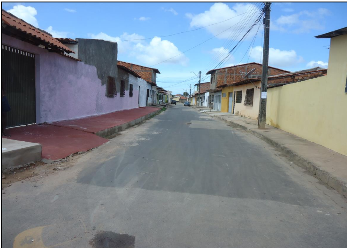
Figura 94: Superfície densamente construída e impermeabilizada no bairro Cidade Operária.
