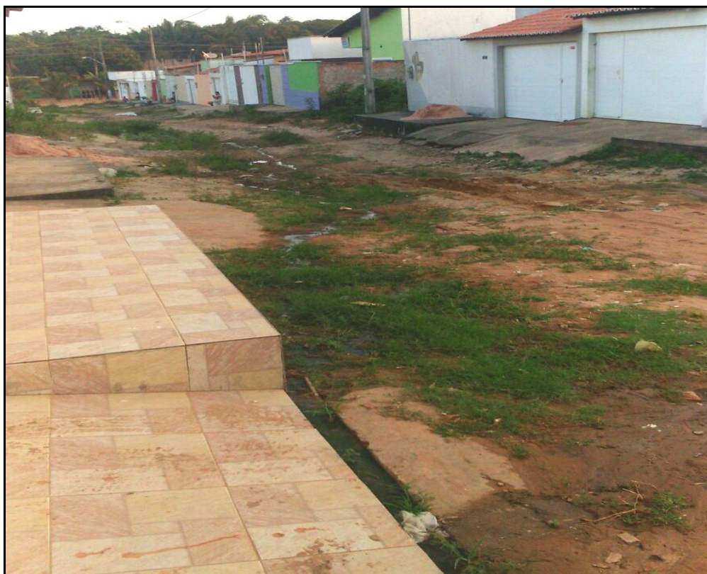
Figura 106: Rua “N” no bairro Jardim Turu I, exemplo de ruas sem pavimentação acometidas de erosão e sem infraestrutura de drenagem.
