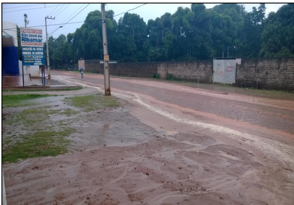
Figura 107: Escoamento superficial e depósito de sedimentos em via do bairro Miritiua.
