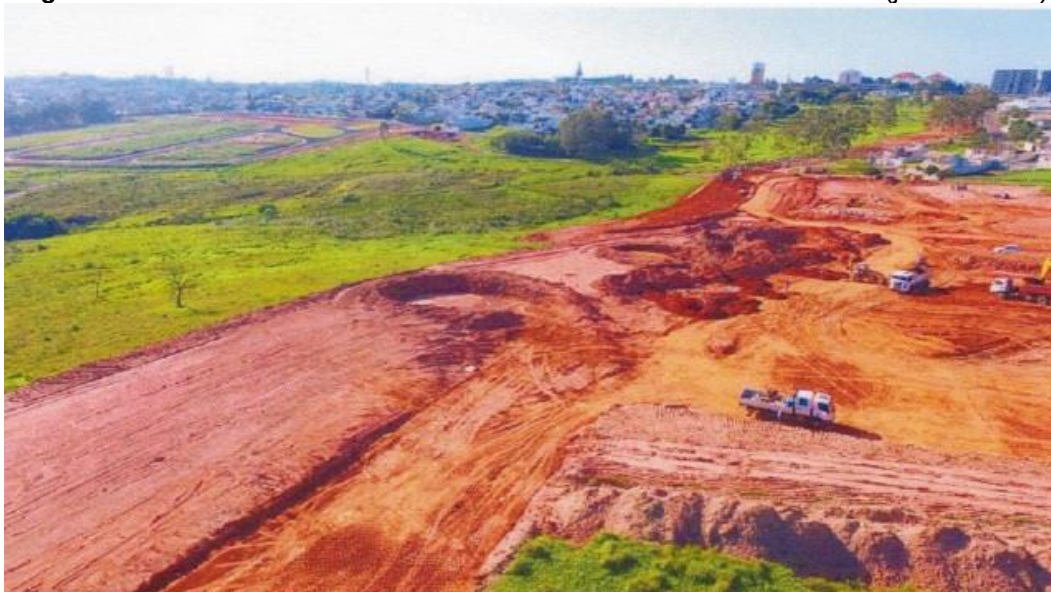
Figura 66: Obras de infraestrutura no Loteamento Residencial Cascata I (janeiro/2019)
