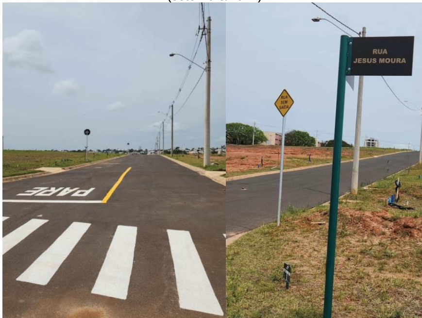
Figura 69: Pavimentação asfáltica e emplacamento nas vias no Loteamento Residencial Cascata I (setembro/2022)
