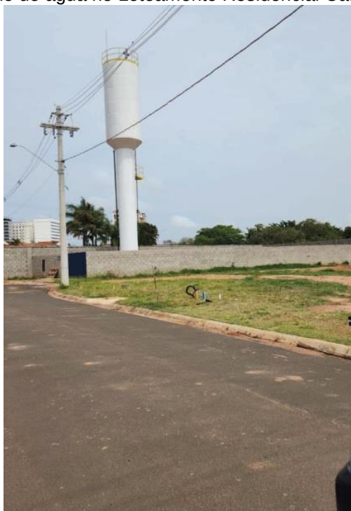
Figura 70: Reservatório de água no Loteamento Residencial Cascata I (setembro/2022)
