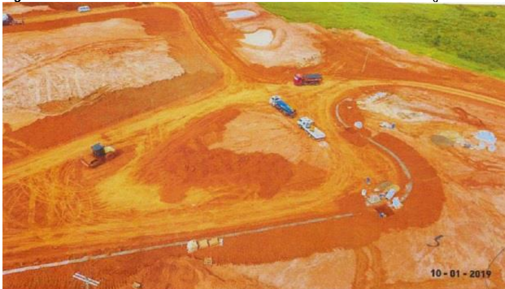
Figura 67: Obras de infraestrutura no Loteamento Residencial Cascata I (janeiro/2019)
