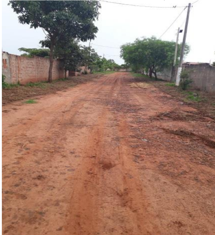
Figura 35: Vista de rua no empreendimento “Barras do Tietê”: pavimento em execução (dez/22)
