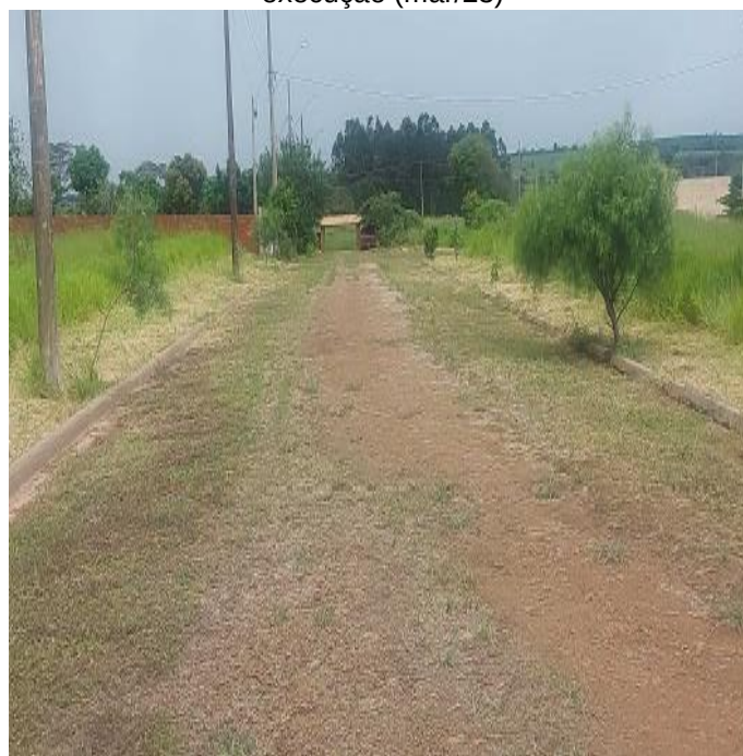
Figura 36: Vista de rua no empreendimento “Barras do Tietê”: arborização concluída e pavimento em execução (mar/23)
