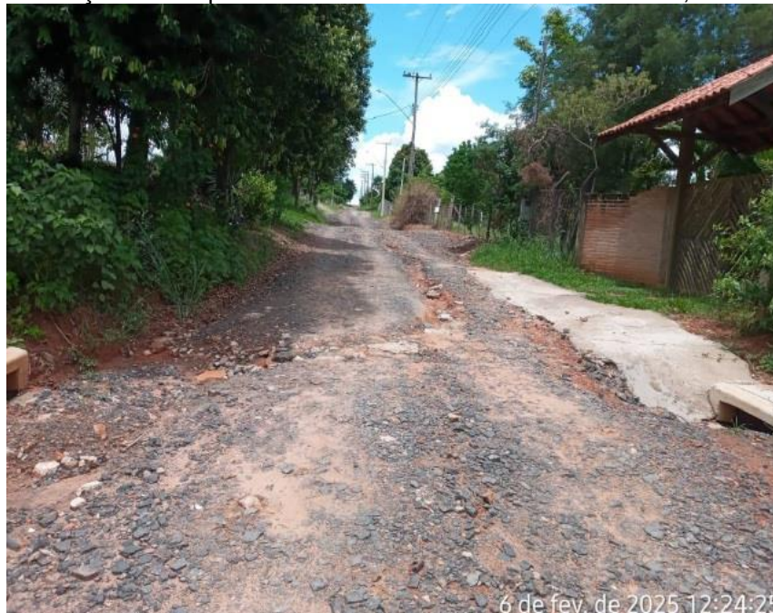
Figura 83: Pavimentação nos empreendimentos “Sítios de Recreio Vila Bela I, II e III” (fevereiro/2025)
