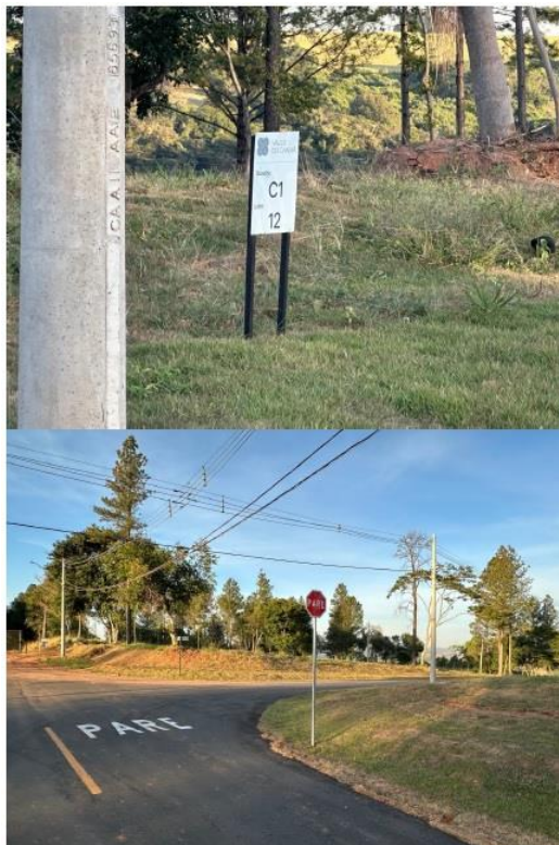
Figura 41: Infraestrutura concluída: Residencial Vale do Canaã – Fase II (quadra C1 – lote 12)
