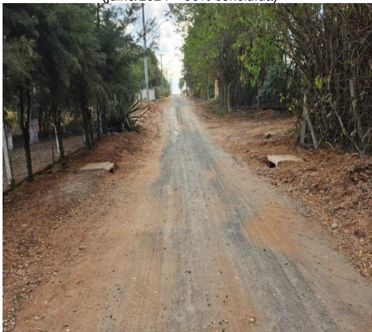
Figura 81: Rede de galeria pluvial nos empreendimentos “Sítios de Recreio Vila Bela I, II e III” (julho/2024 – 90% concluída)
