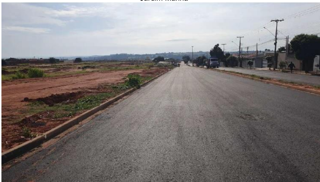
Figura 43: Pavimentação asfáltica concluída na Av. José Rino - Loteamento de Interesse Social “Jardim Marina”
