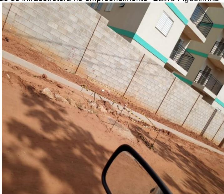
Figura 64: Obras de infraestrutura no empreendimento “Bairro Figueirinha” (setembro/2024)
