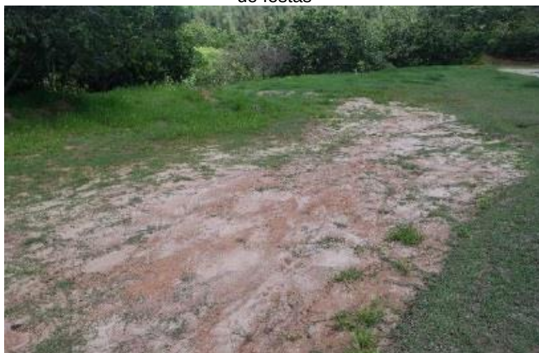
Figura 52: Carreamento de sedimentos em direção ao corpo d'água decorrente das obras do salão de festas
