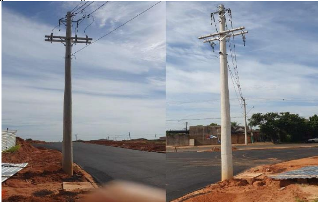
Figura 44: Rede de energia elétrica concluída - Loteamento de Interesse Social “Jardim Marina”
