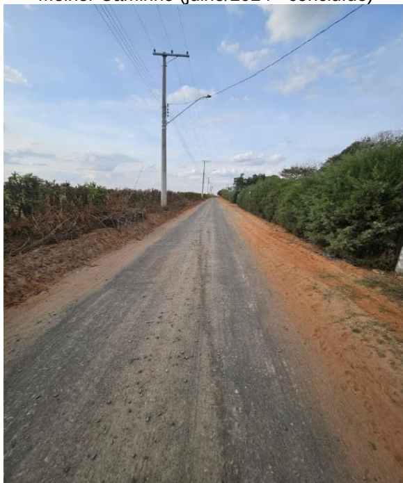
Figura 79: Pavimentação nos empreendimentos “Sítios de Recreio Vila Bela I, II e III” – Programa Melhor Caminho (julho/2024 - concluído)
