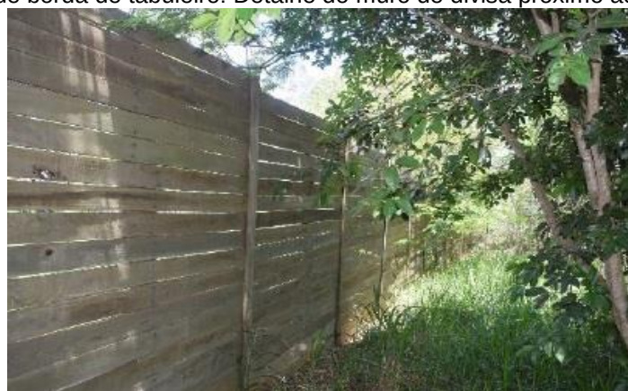
Figura 53: APP de borda de tabuleiro: Detalhe do muro de divisa próximo ao campo de futebol
