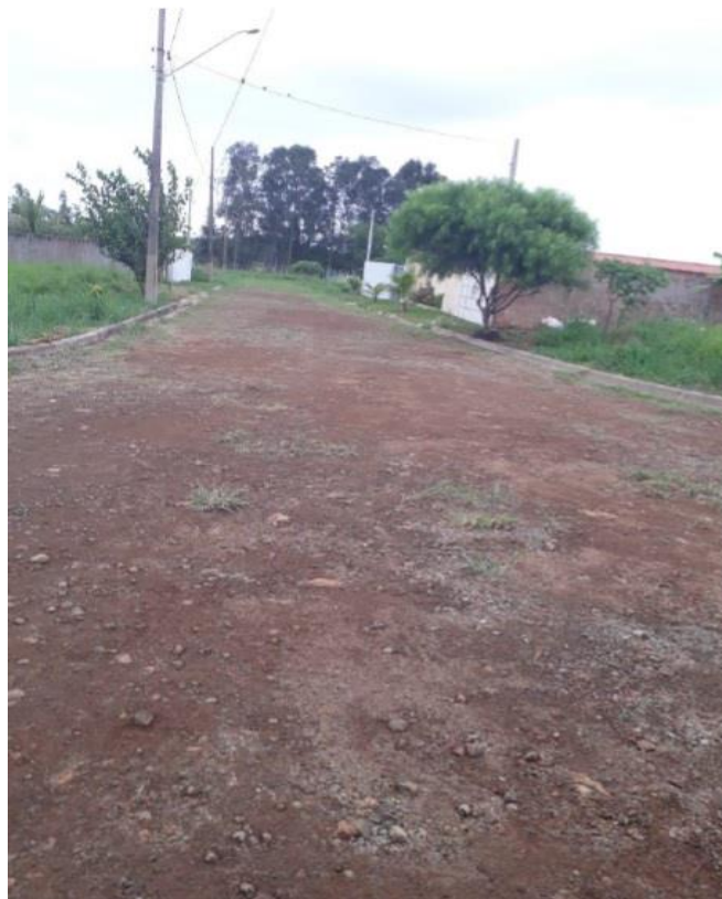
Figura 37: Vista de rua no empreendimento “Alvorada Clube dos Vinte”: pavimento em execução (dez/22)
