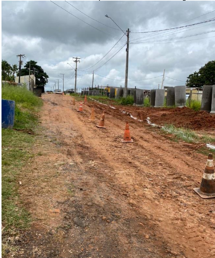
Figura 61: Obras de infraestrutura no empreendimento “Bairro Figueirinha” (março/2023)
