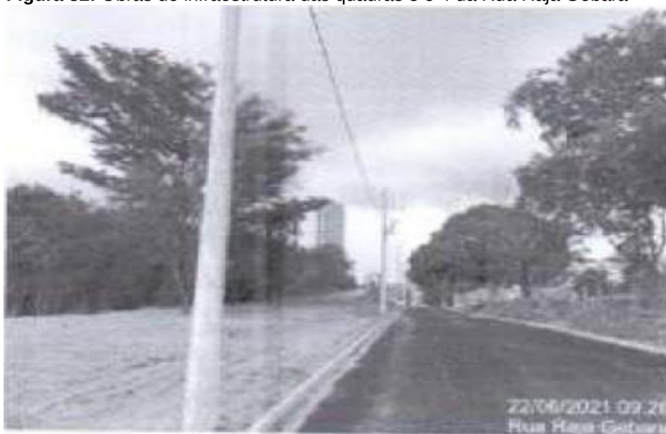
Figura 32: Obras de infraestrutura das quadras 3 e 4 da Rua Raja Gebara
