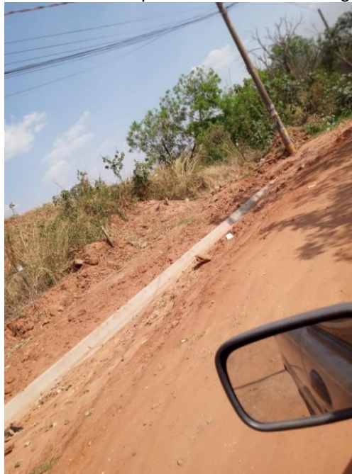
Figura 63: Obras de infraestrutura no empreendimento “Bairro Figueirinha” (setembro/2024)
