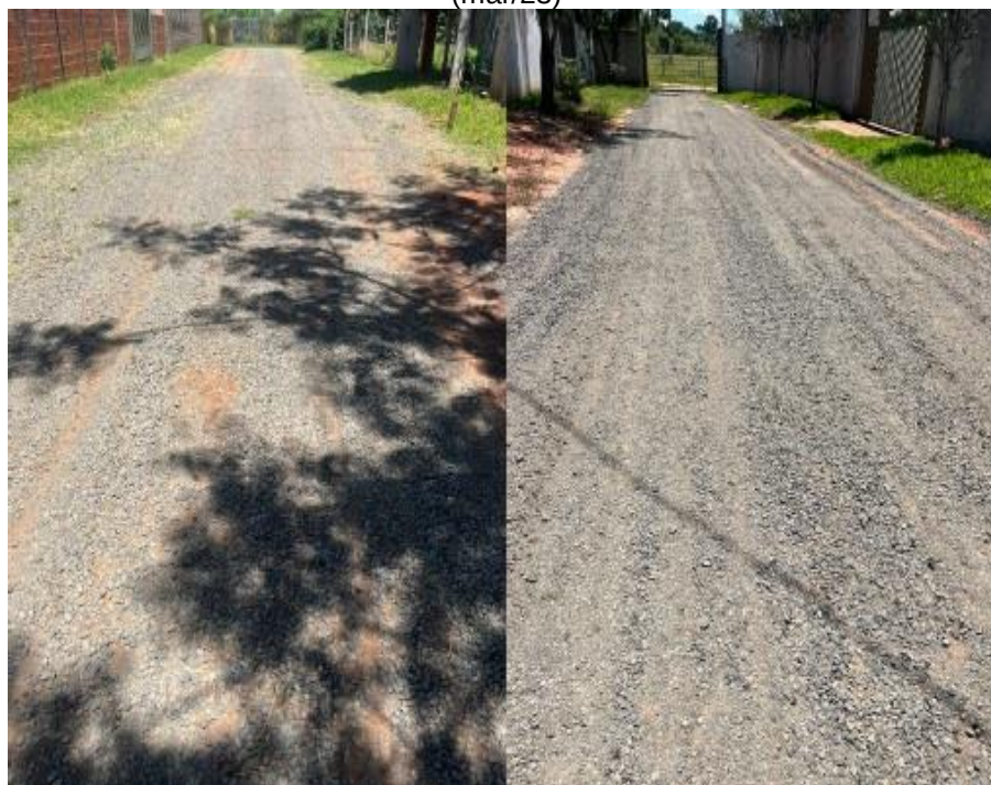
Figura 38: Vista de rua no empreendimento “Alvorada Clube dos Vinte”: pavimento concluído (mar/23)
