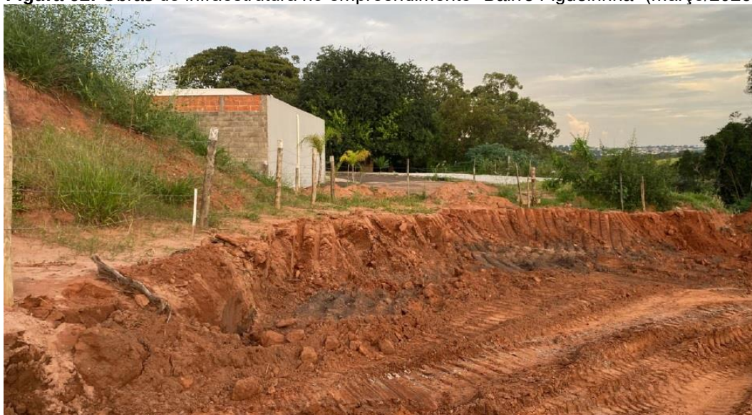
Figura 62: Obras de infraestrutura no empreendimento “Bairro Figueirinha” (março/2023)
