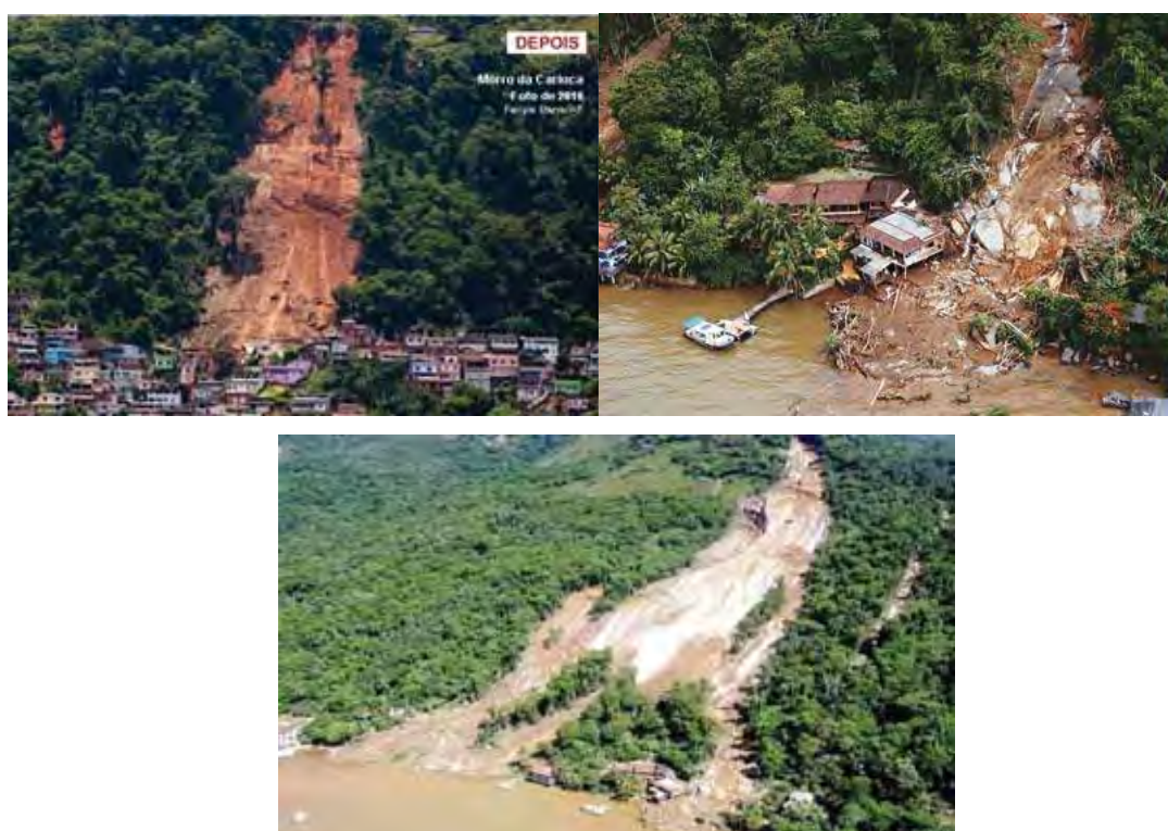
Figura 11 – Deslizamentos no Morro Carioca e na Enseada do Bananal no município de Angra dos Reis, RJ, Reveillon 2009-2010
