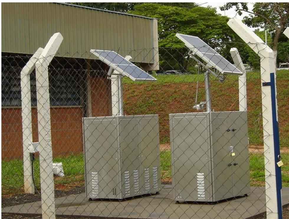
**Figura 49 – Armários de aço e Painéis Fotovoltaicos instalados em campo**
