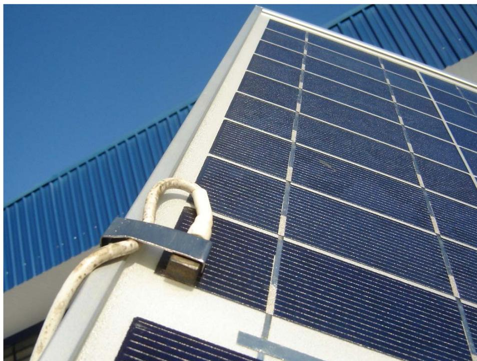
**Figura 61 – Detalhe do sensor de temperatura sobre a superfície do painel fotovoltaico**
