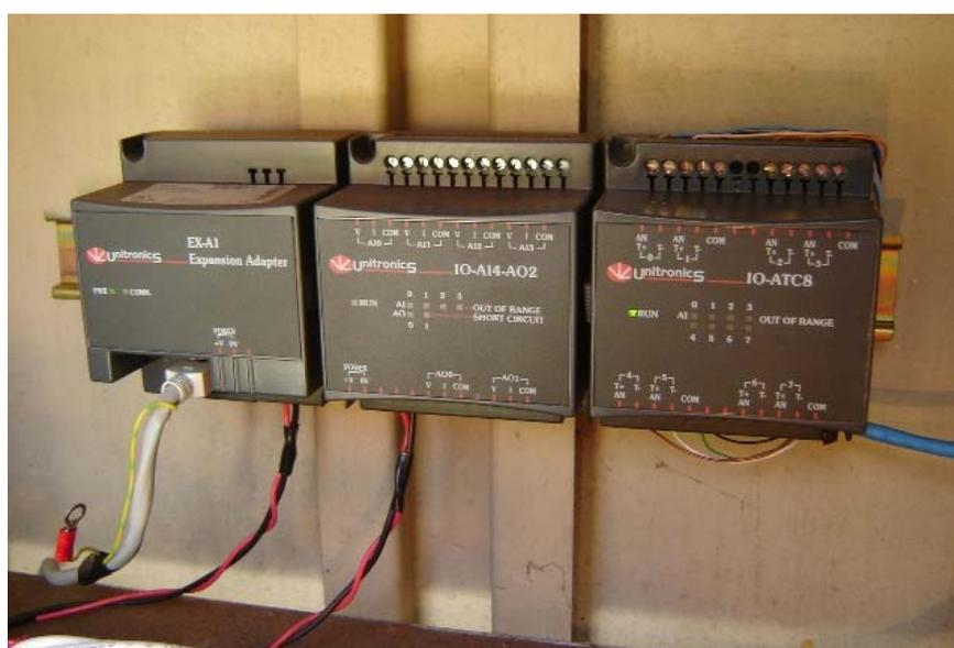
Figura 47 – Conjunto de módulos de expansão do CLP
