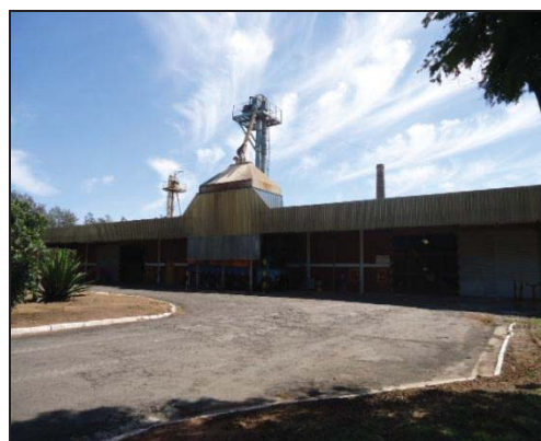
Figura 51 – Graneleiro de fundo plano para o armazenamento do farelo moído.
