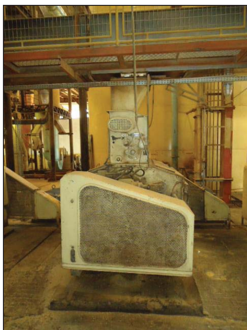
Figura 33 – Vista lateral do laminador.
