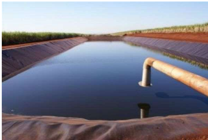
Figura 10: Lagoa de usina de cana-de-açúcar destinada para resfriamento de vinhaça.
