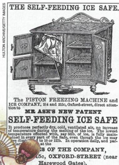
**FIGURA 2.** Caixa de gelo utilizada em casas estadunidenses na década de 1870. A porta superior esquerda era reservada para armazenar blocos de gelo, vendidos de porta em porta. A água derretida do gelo escorria por tubulações e depositava-se numa vasilha na parte inferior do aparato.
