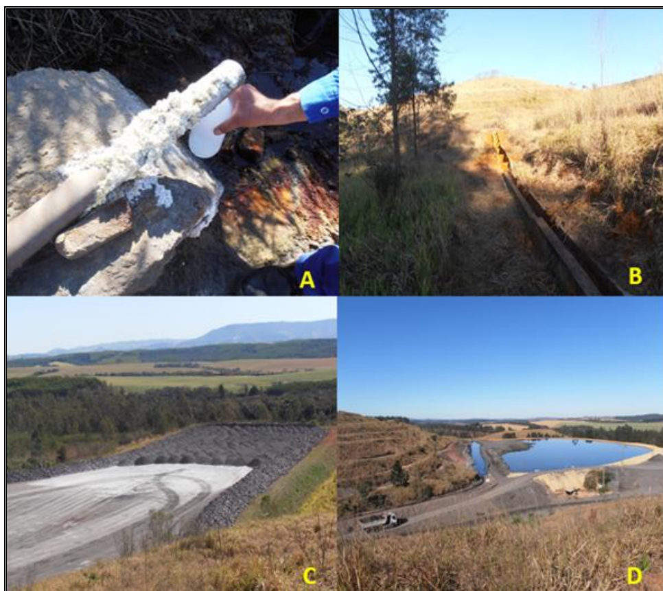
Figura 10 – Amostragem de efluente ácido gerado nos depósitos de rejeito (A), sistema de coleta e drenagem dos efluentes nos depósitos (B), adição de carbonato de cálcio (CaO) aos rejeitos para controlar a acidez do efluente gerado (C) e lagoa de decantação dos efluentes drenados a partir dos depósitos na mina de carvão em Figueira (PR).
