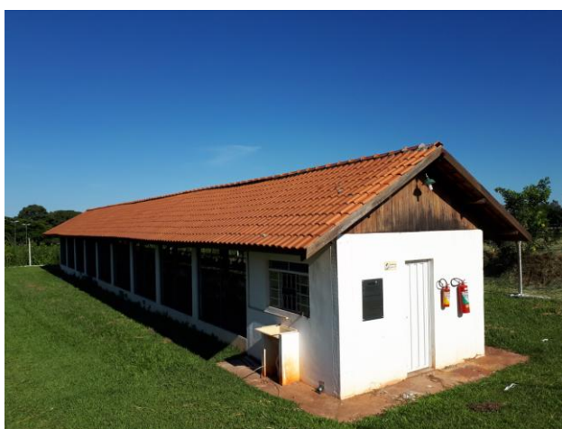
Figura 4. Galpão para galinhas poedeiras. Fonte: Do próprio autor.
