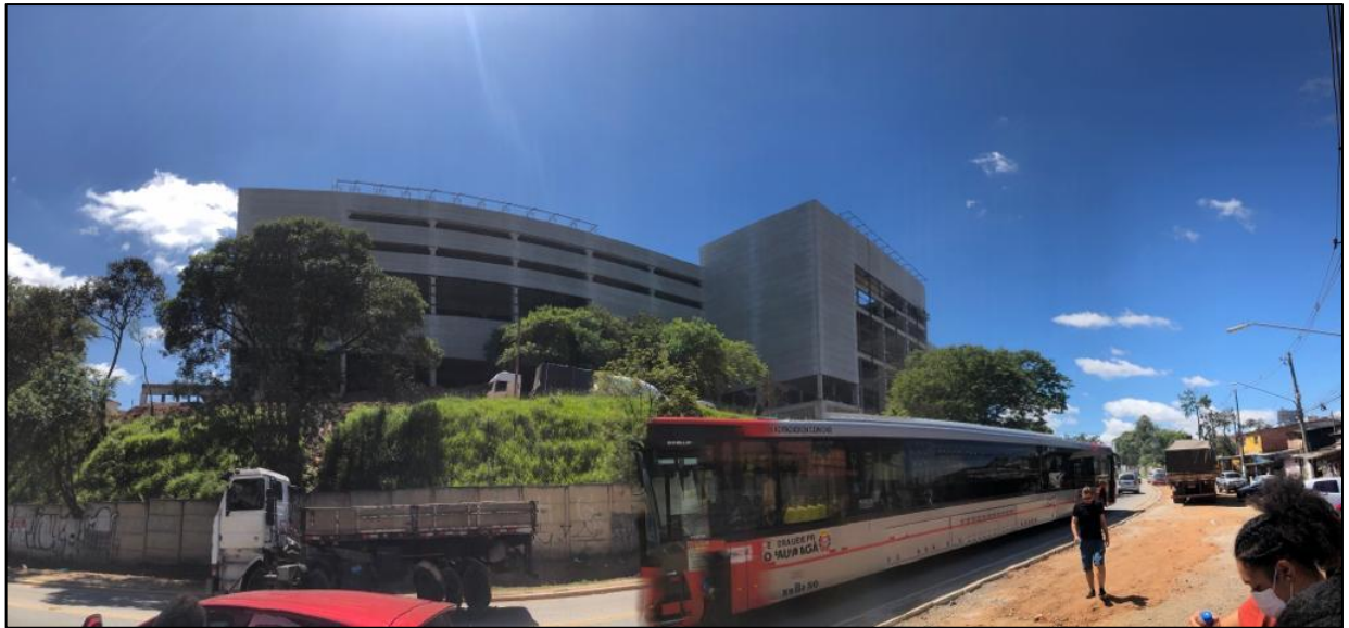
Figura 8 - Obra de empreendimento comercial. Cidade Tiradentes. 2021.
