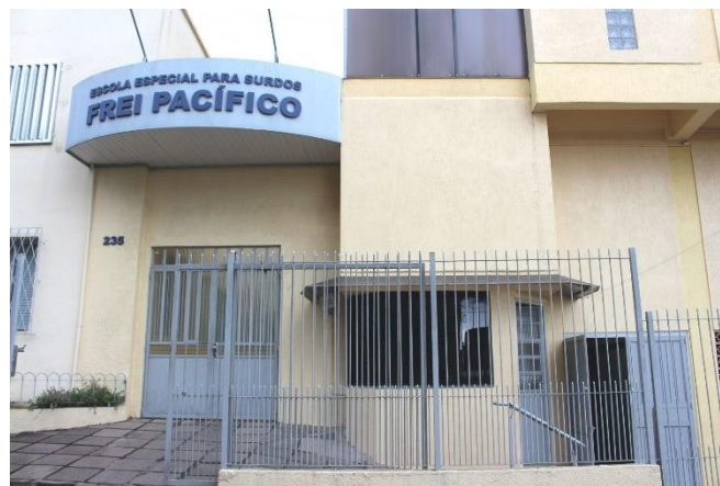
Figura 2 – Fachada da Escola Especial para Surdos Frei Pacífico.
