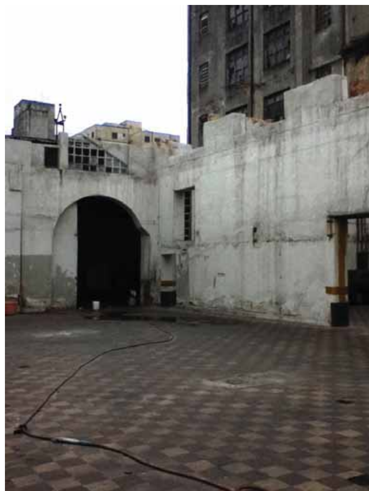
Figura 41. Área que teve sua cobertura demolida
