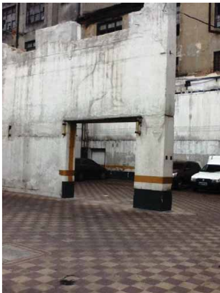
Figura 40. Área em que ficava o mezanino que foi demolido
