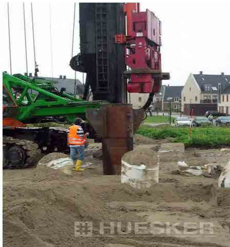
Figura 11 – Execução de coluna Ringtrac® (fonte: www.huesker.com.br )
