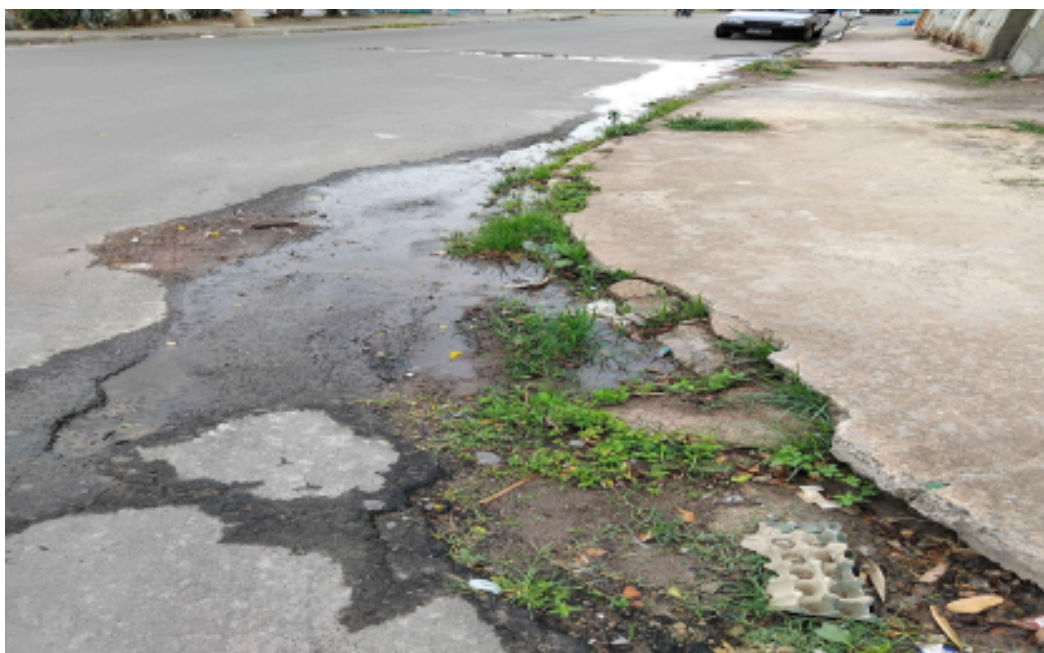
Figura 2: . Calçada quebrada e esgoto a céu aberto no bairro Jardim Bonsucesso em Rio Claro-SP. Fonte: Jacqueline Leal da Silva. Data: 13 de outubro de 2025
