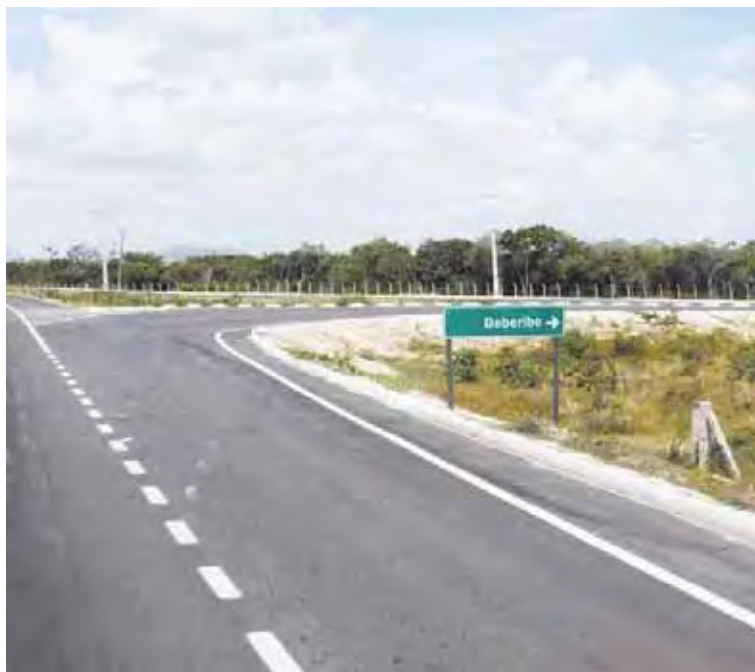
Figura 13 – Estrada de Acesso aos municípios do litoral leste, CE-040 (2012).
