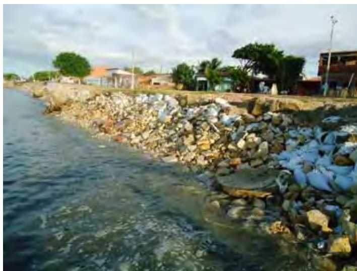
Figura 16 - Contenção do Mar em Barrinha - Icapuí, praia do Litoral Leste do Ceará.
