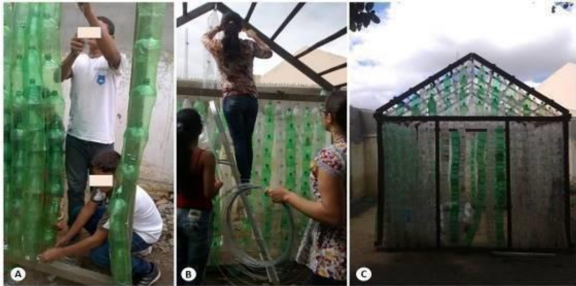
Figura 5: Oficina realizada com alunos para a construção de uma estufa com material reciclado.
