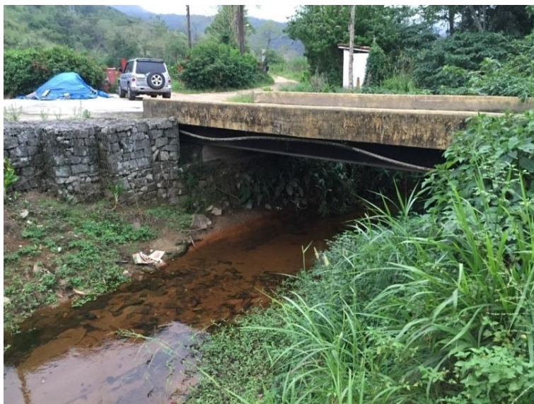
Figura 5 - Ponte sobre Rio da Marafunda.
