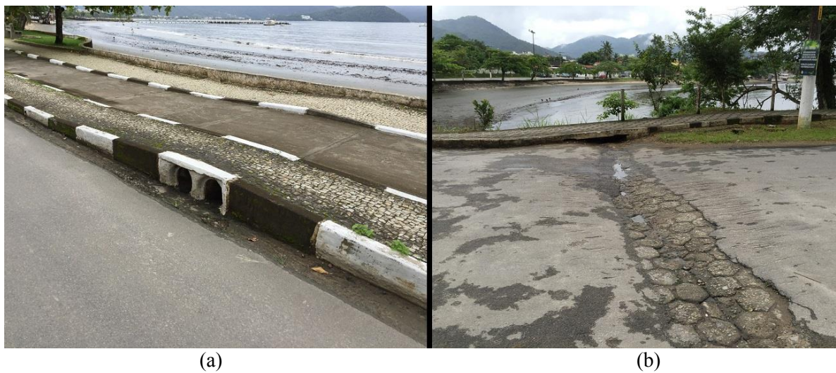
Figura 15 - Bueiro sob ciclovía e valeta com boca de lobo.
