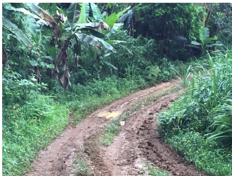
Figura 25 - Trecho em péssimas condições em época chuvosa.
