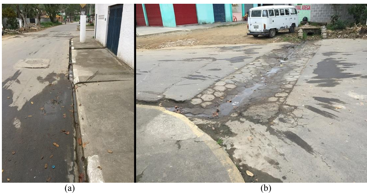
Figura 2 - Canal na margem (a) e valeta transversal (b).
