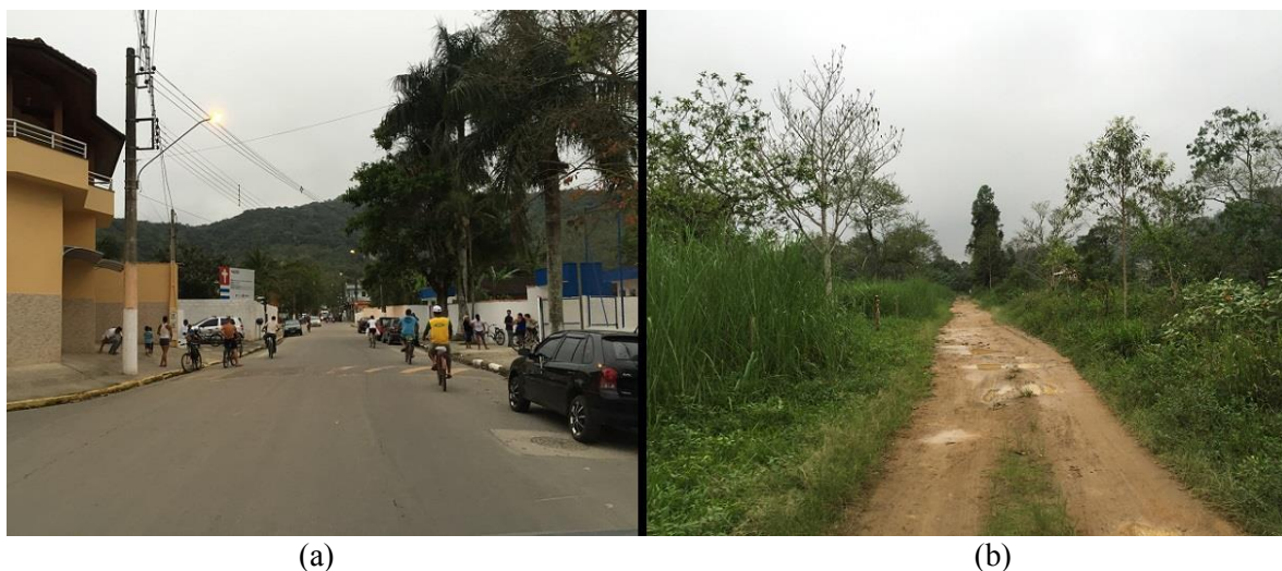
Figura 4 - Segmento 1 pavimentado (a) e 2 sem pavimento (b).
