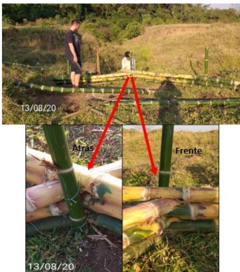
Figura 7 - Construção do Barramento com montagem em ‘V’
