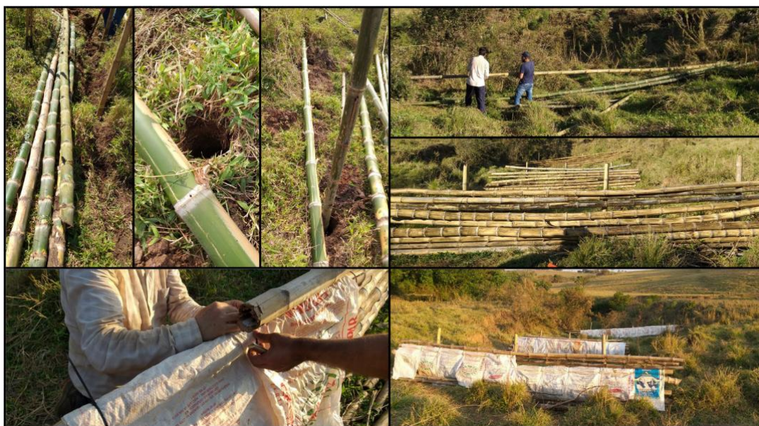
Figura 4 - Construção dos barramentos (Ravina 1)
