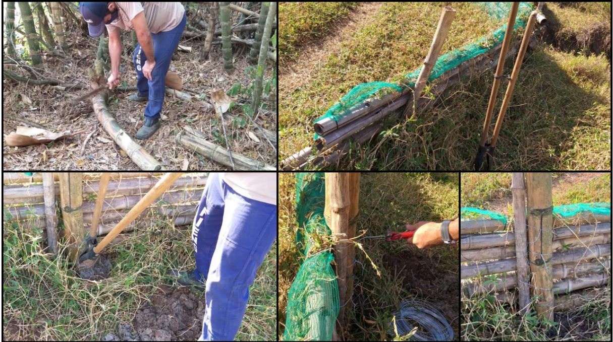
Figura 11 - Reforço no barramento 4 da Ravina 2
