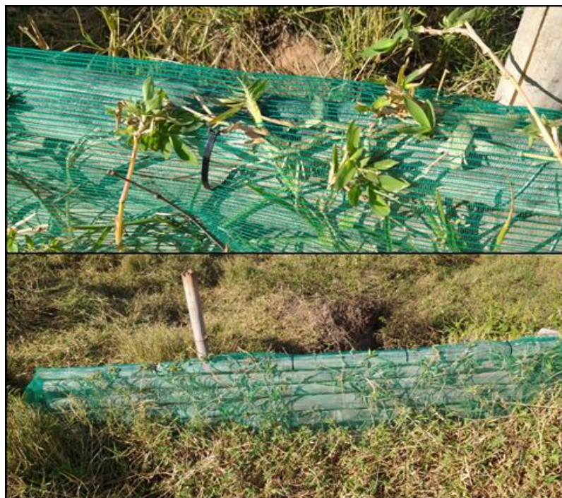
Figura 12 - Substituição de abraçadeiras danificadas
