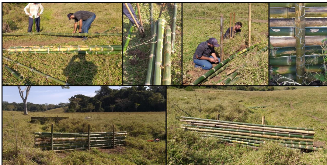
Figura 6 - Construção dos barramentos (Ravina 2)
