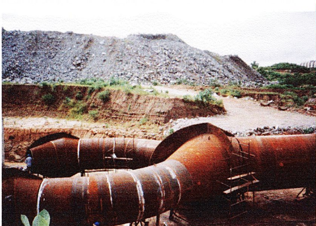
Figura 4.4 – Bifurcação em fase de montagem em obra
