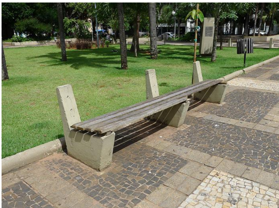
Figura 58 – Banco com encosto e assento quebrado são recorrentes
