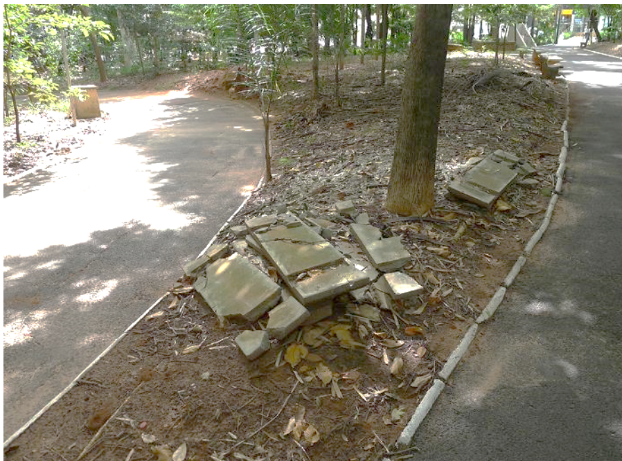
Figura 43 – Bancos completamente destruídos
