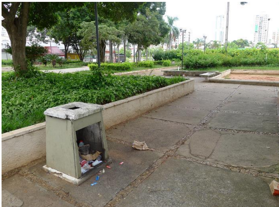
Figura 71 – Única lixeira de concreto está danificada
