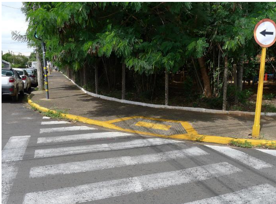
Figura 29 – Guia rebaixada e sinalização adequada
