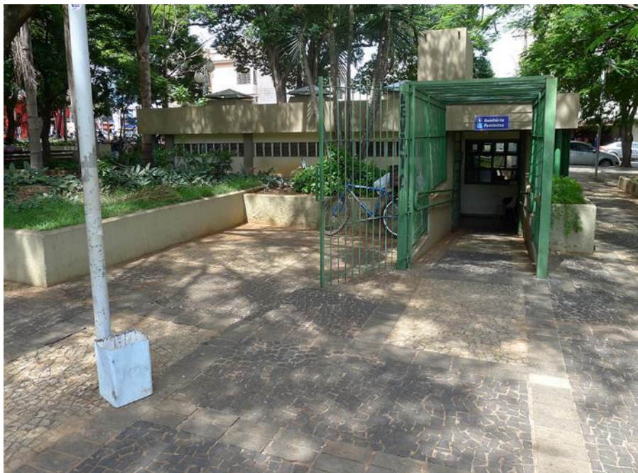
Figura 53 – Banheiro público constantemente vandalizado
