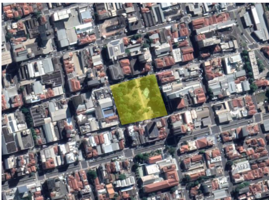
Figura 45 – Vista aérea da Praça Rui Barbosa
