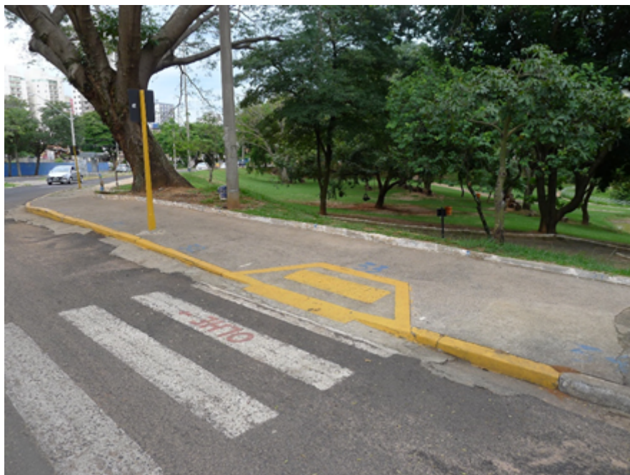
Figura 13 – Guia rebaixada e sinalizada
