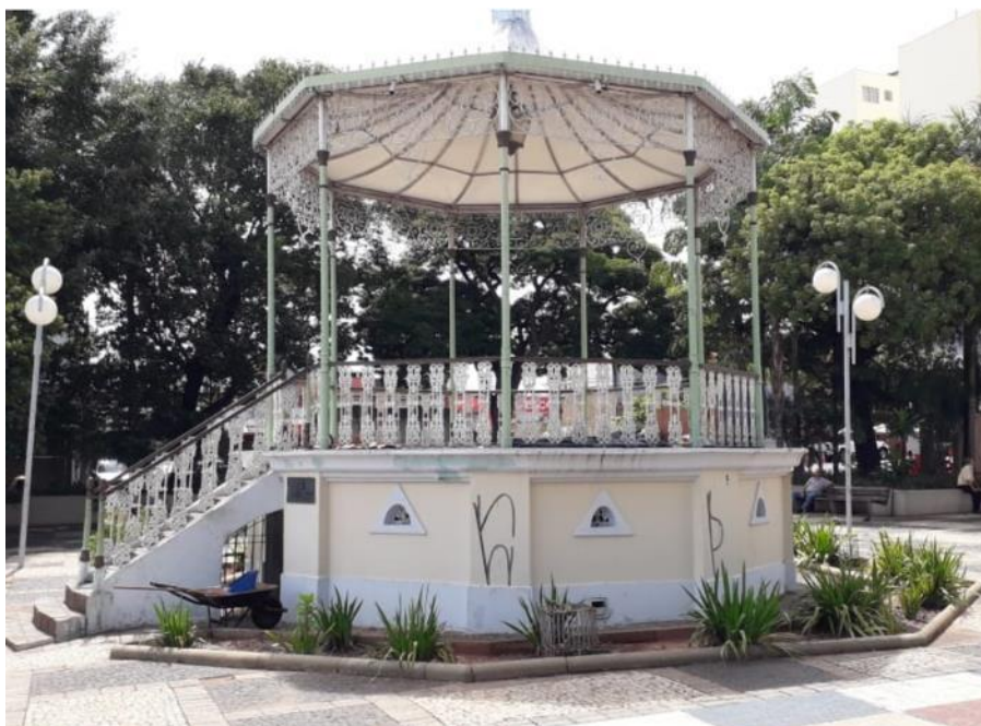
Figura 47 – Coreto da praça serve de abrigo para moradores de rua
