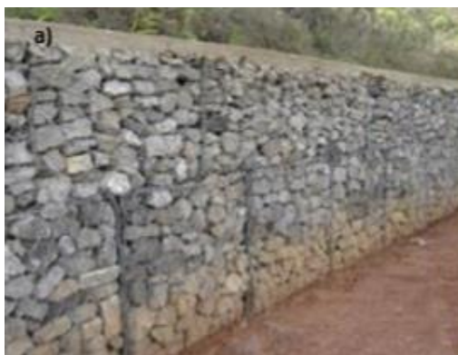
Figura 4. Muro de gabião tipo caixa
