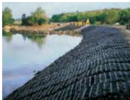
Figura 5. Instalação de geocolchão concluída
