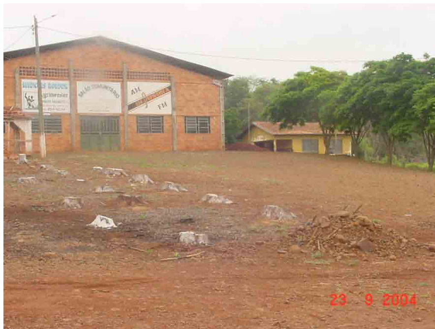
Fotografia 9 – Escola e Pavilhão
