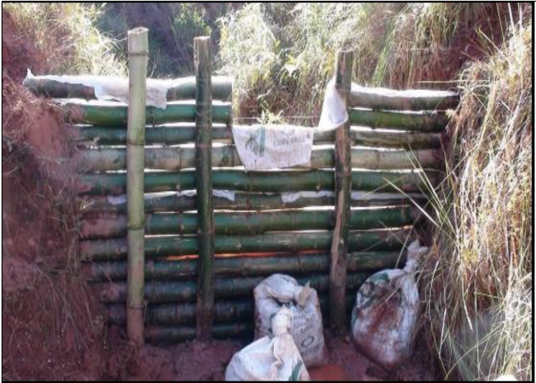
Figura 21– Técnica de paliçada de bambu
