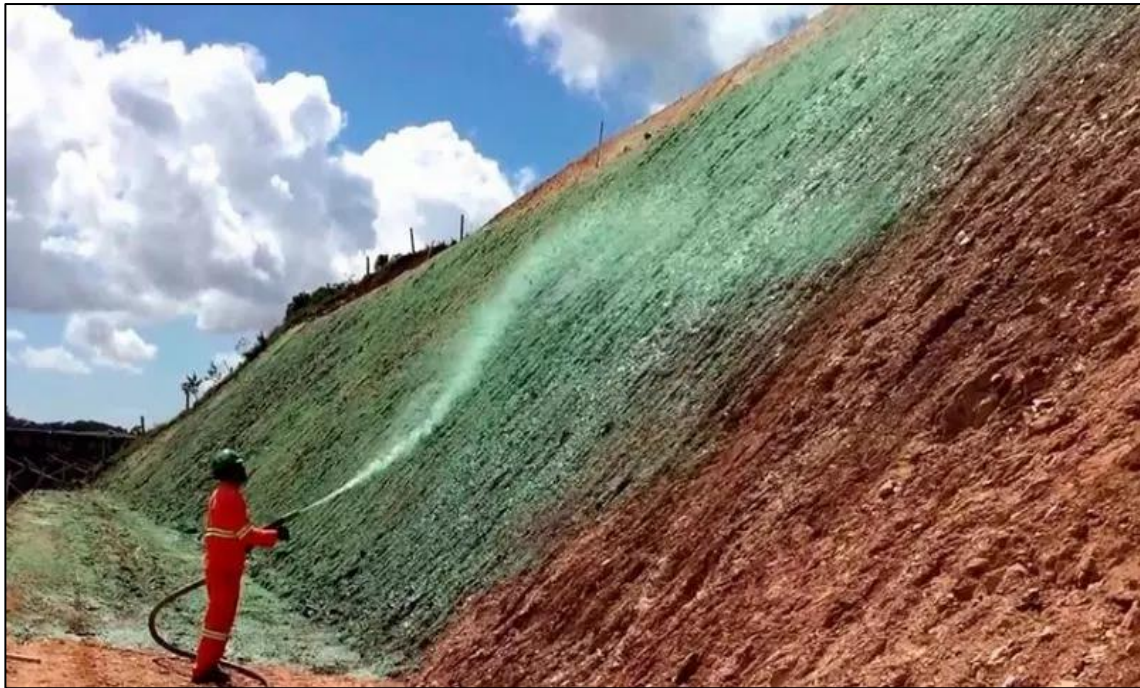
Figura 17- Plantio Mecanizado ou Hidrossemeadura.
