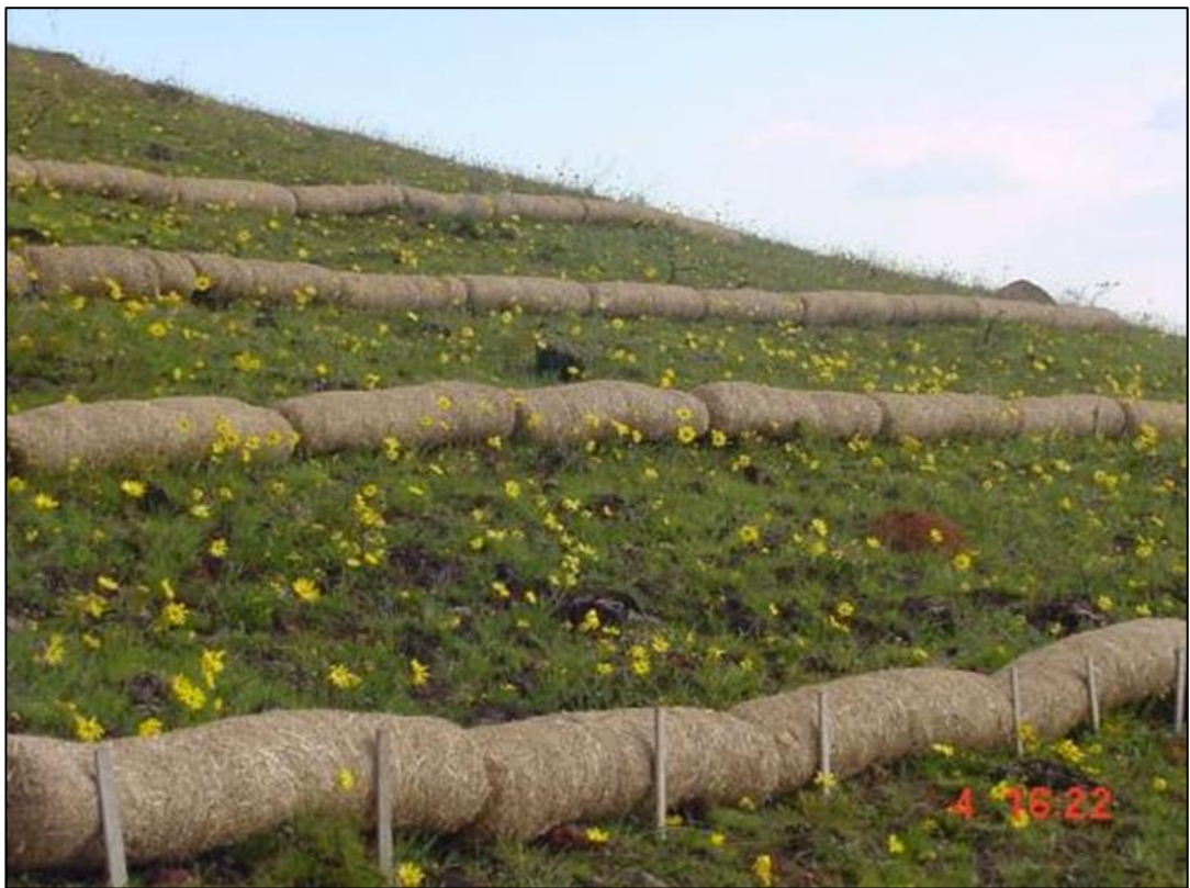
Figura 19- Retentores de fibras vegetais como técnica de bioengenharia.
