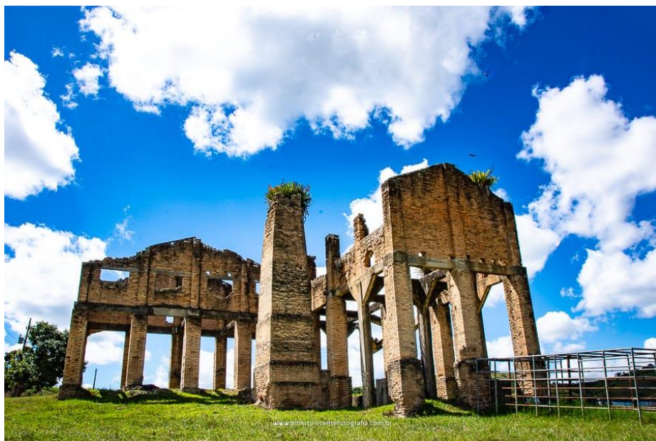
Figura 18 – Destroços da Usina Vitória – Atalaia Alagoas
