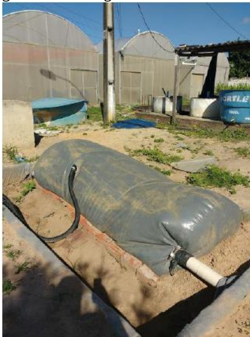
Figura 11 – Biodigestor caseiro construído
