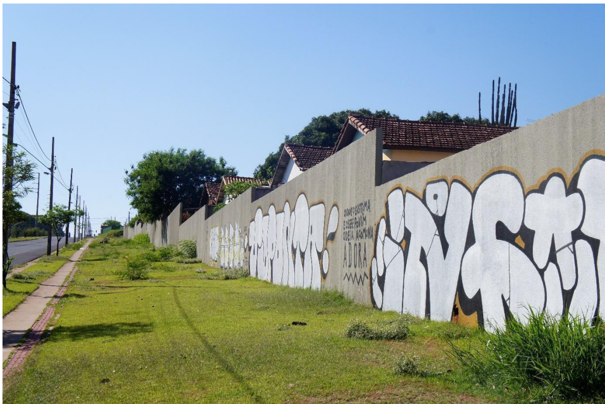
Figura 9– Fotografia do muro de arrimo e extensão das calçadas entre a avenida Cerro Azul e o conjunto habitacional Santa Felicidade. Maringá. 2019.
