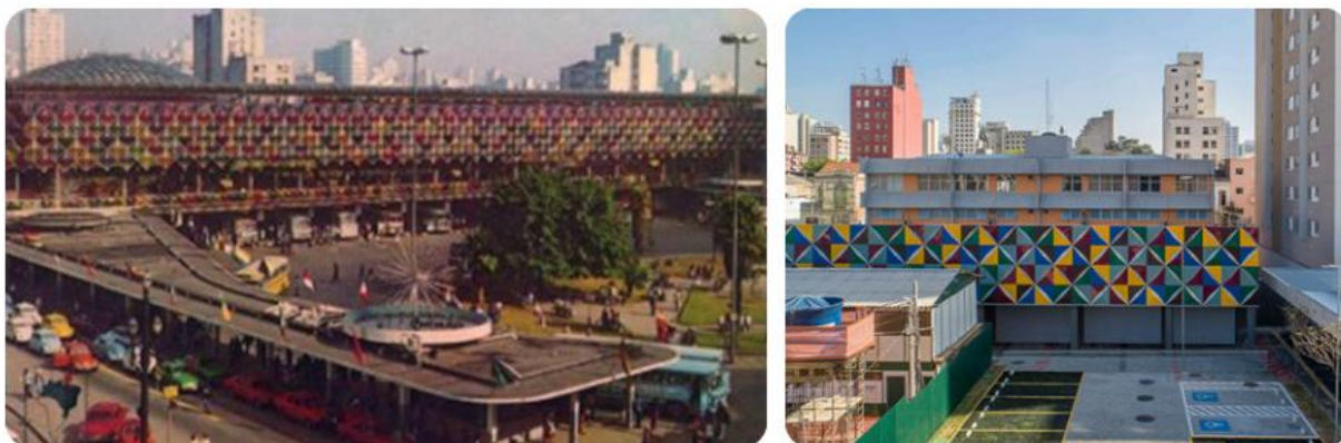
Figura 35. Terminal Rodoviário da Luz (à esquerda); Detalhe da fachada do pátio interno do Complexo Júlio Prestes (à direita)
