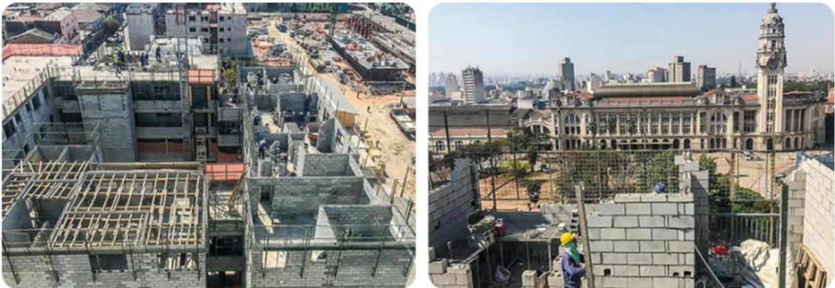
Figura 60. Obra do Complexo Júlio Prestes – sistema construtivo
