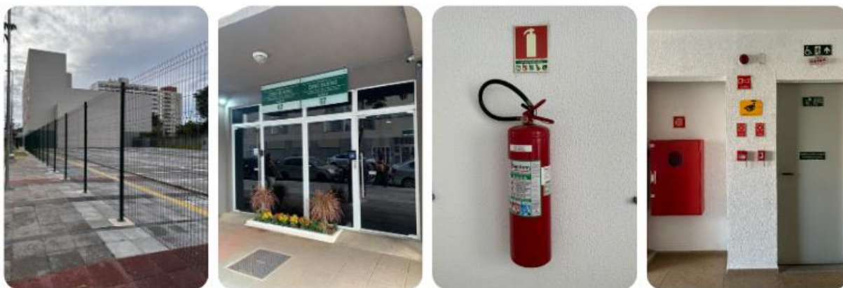
Figura 63. Portaria e equipamentos de segurança do Complexo Júlio Prestes
