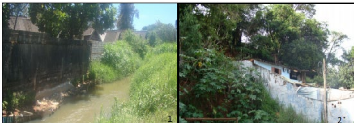
Figura 27 - Ocupação em área de risco de inundação (1) e de deslizamento (2) em Atibaia/SP Fonte: CPRM (2012)
