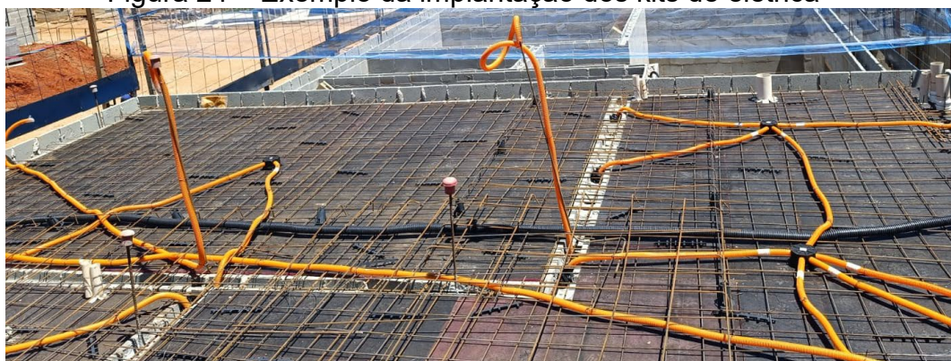
Figura 24 – Exemplo da implantação dos kits de elétrica
