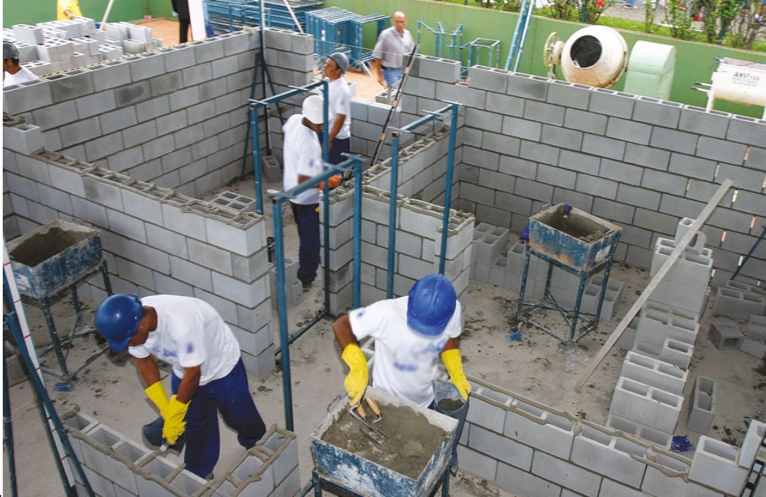
Figura 3 - Execução de alvenaria estrutural com blocos de concreto em obra.
