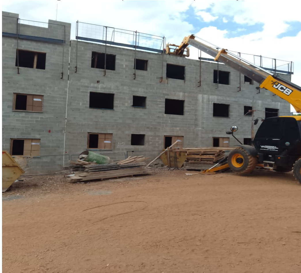
Figura 20 – Transporte de material para as Lajes
