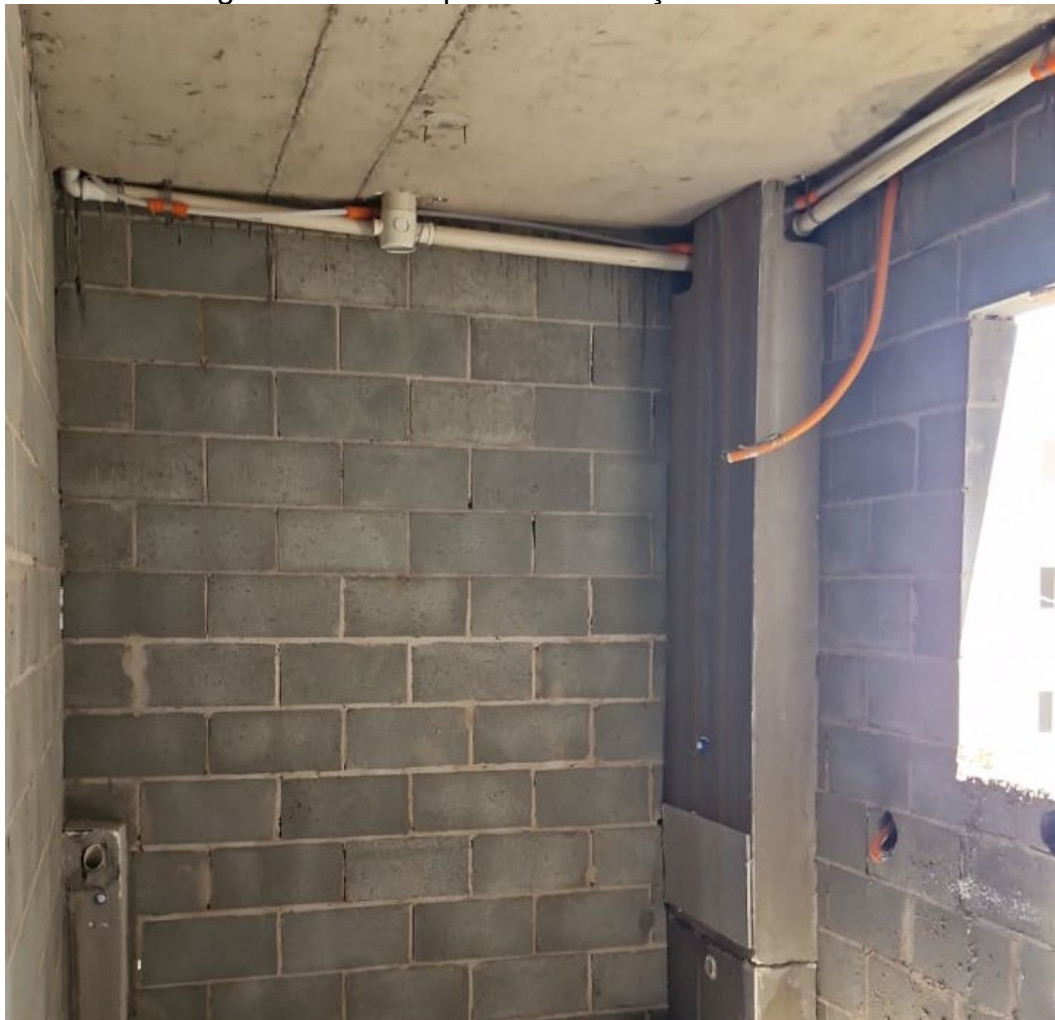
Figura 10 – Exemplo das Instalações Hidráulicas
