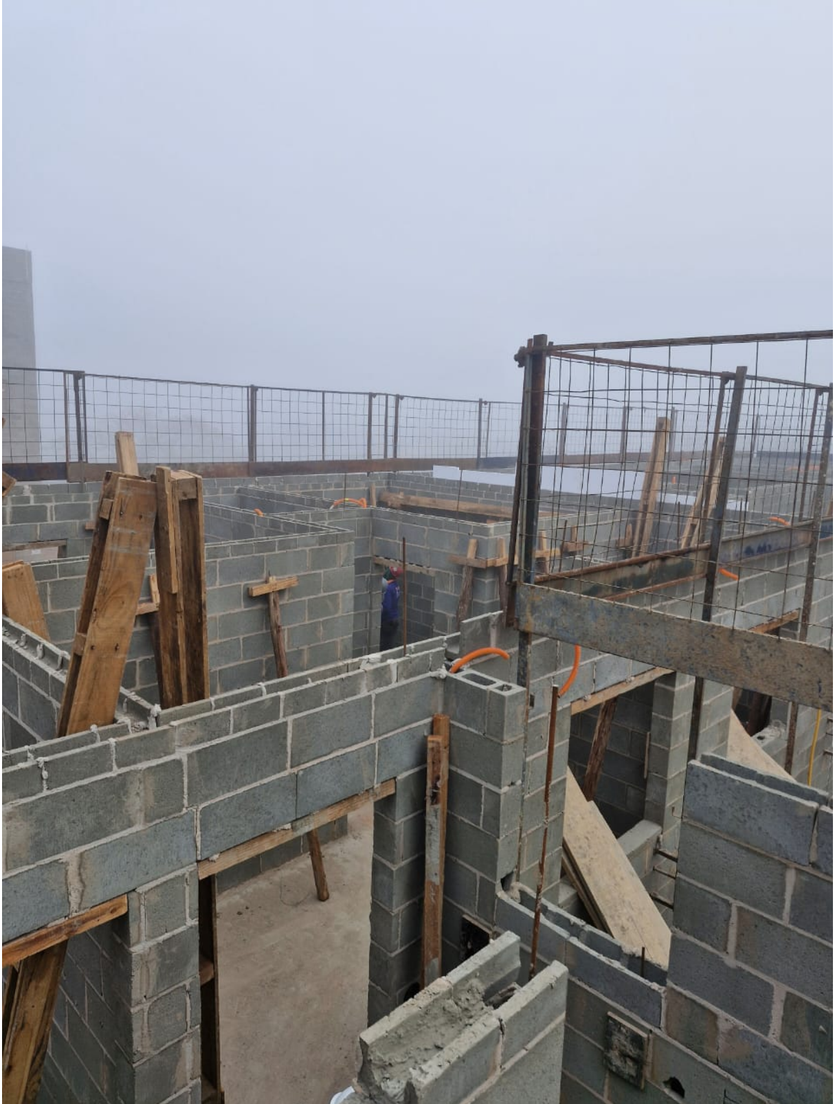
Figura 9- Exemplo de Elevação da Paredes e Grauteamento das Canaletas
