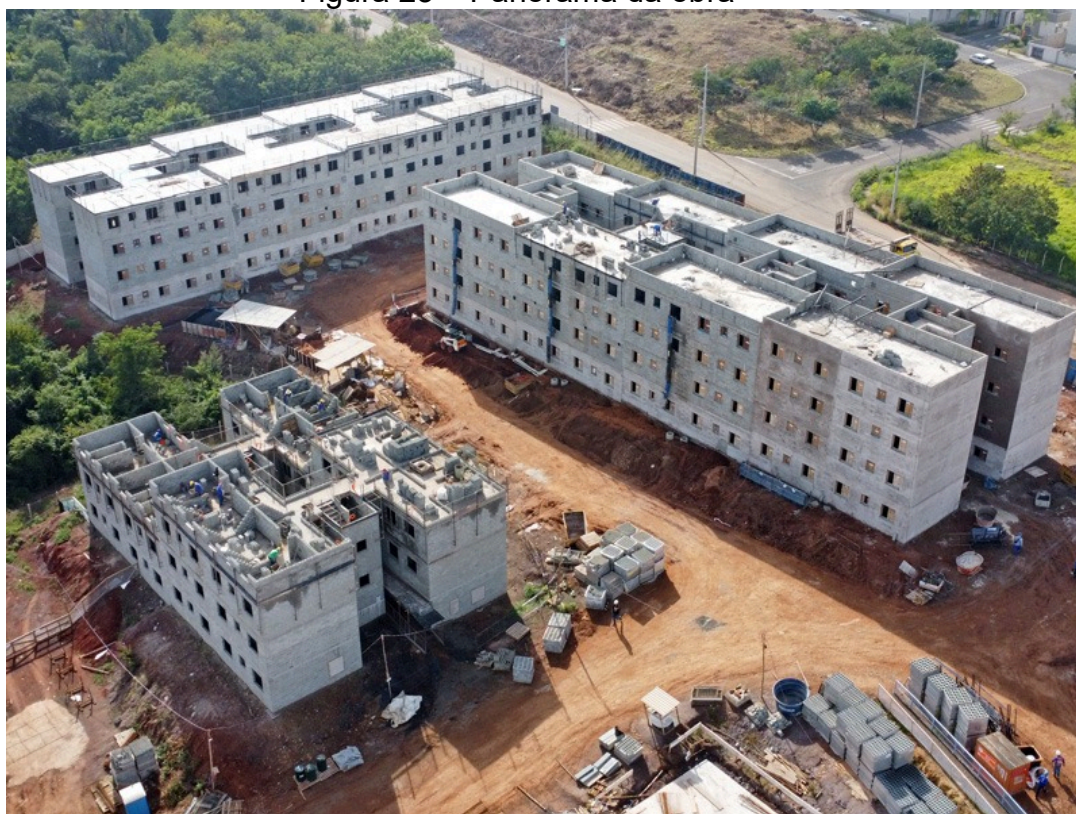
Figura 23 – Panorama da obra
