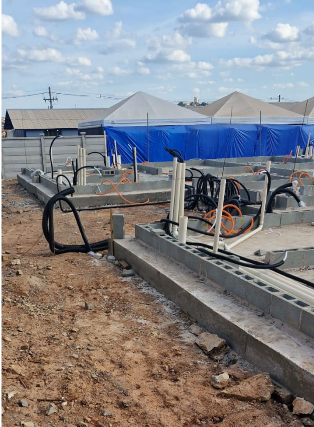
Figura 8- Exemplo de Marcação e Primeira fiada
