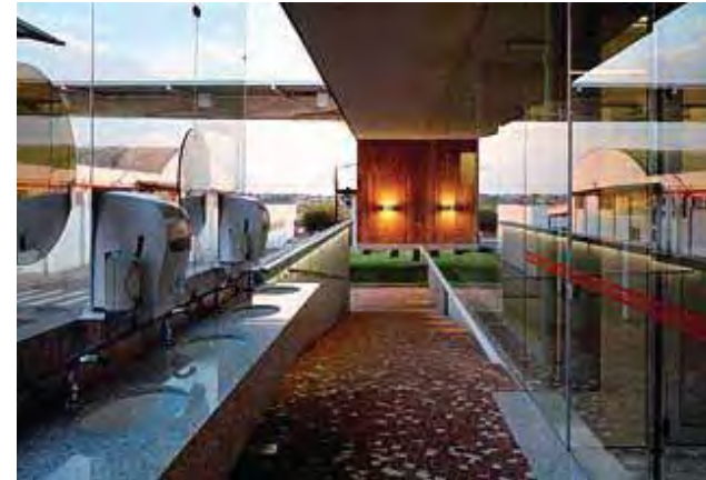
Imagem 25: Lavatórios da rampa de acesso ao restaurante fabril Marilan-SP
