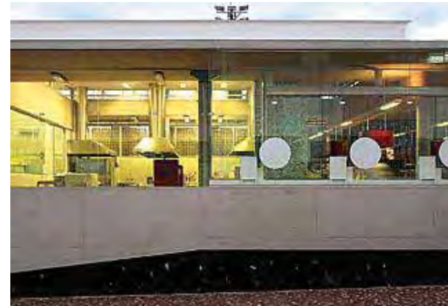
Imagem 23: Panos de vidro da cozinha do restaurante fabril Marilan-SP
