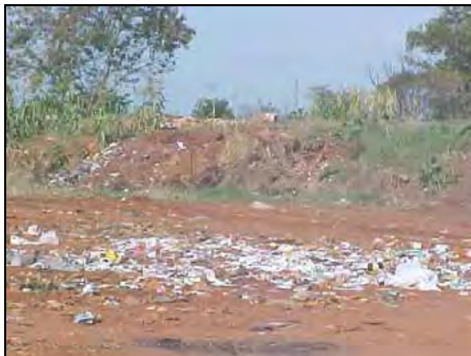
Foto 4 – Disposição dos resíduos sólidos na forma de lixo no aterro controlado de Teodoro Sampaio-SP. Não há mais vala.
