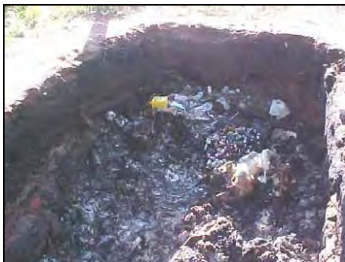
Foto 6 – Disposição dos RSS na área do aterro em valas de Teodoro Sampaio-SP Fonte: Fagundes, 2007.
