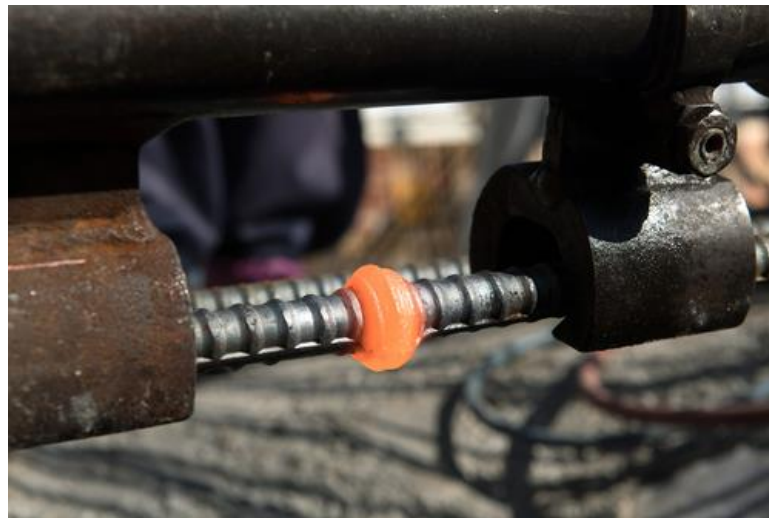
Figura 17 - Soldagem a quente por pressão
