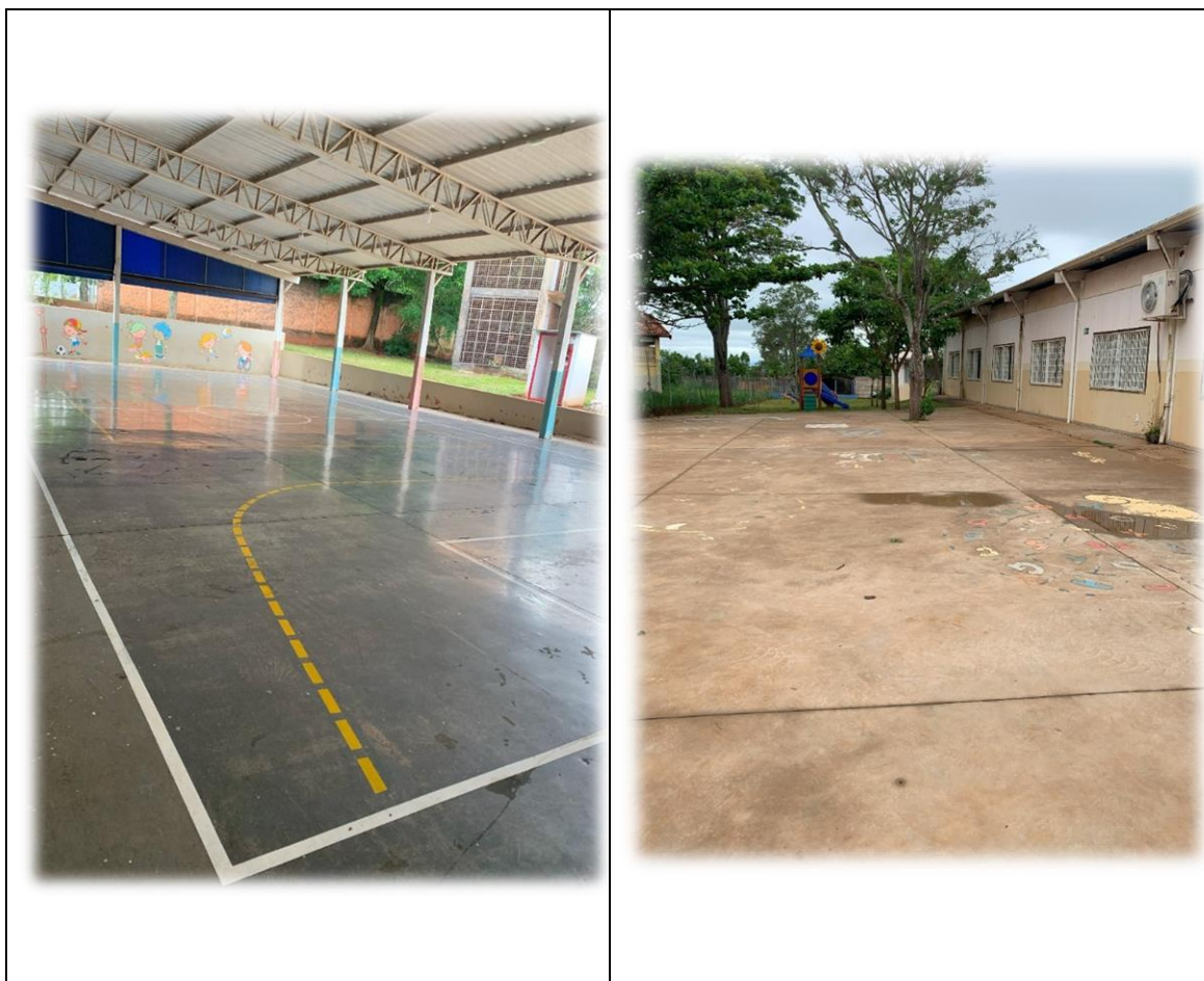
Figura 12 - Espaço destinados à Educação Física da Escola (pátio coberto); Figura 13 - Espaço destinados à Educação Física da Escola
