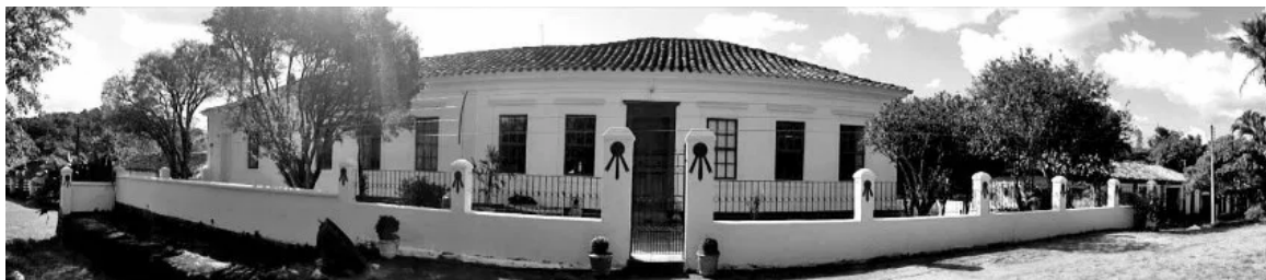
Figura 16. Casa sede. Fonte: REIS (2018)
