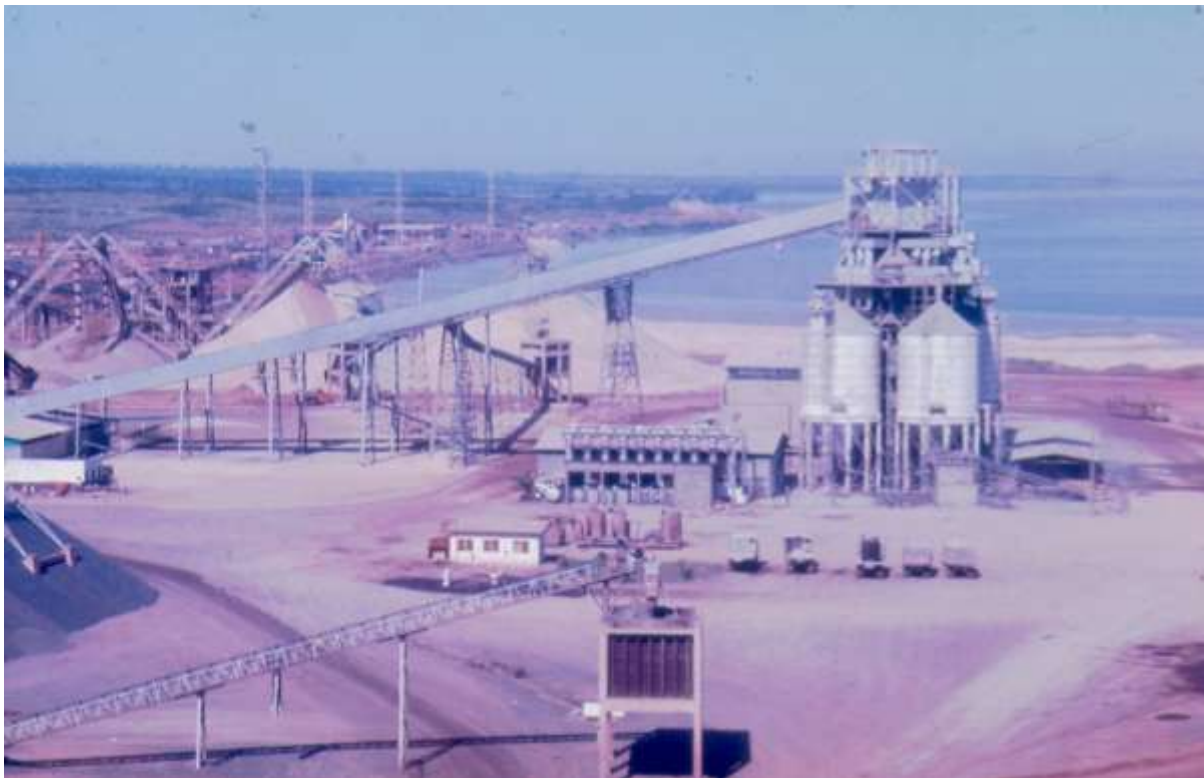
Canteiro industrial em Ilha Solteira.
