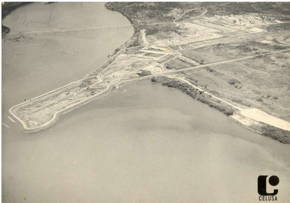
Ensecadeira e canteiro de obras em Jupia- 1961.
