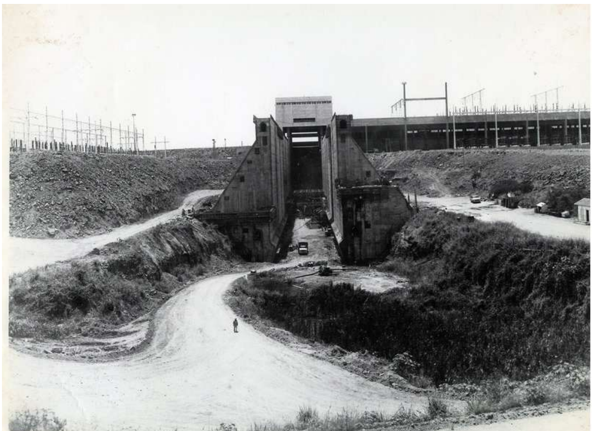
Eclusa Hidrelétrica Jupia
