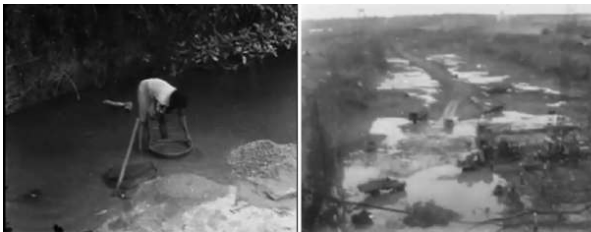
Garimpagem na construção do Complexo Hidrelétrico Urubupungá.
