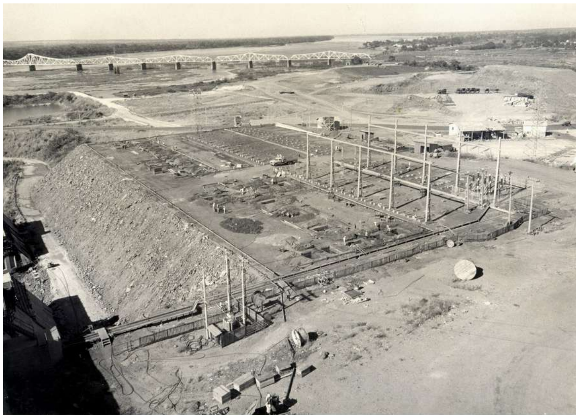
Ponto de intersecção entre hidrelétrica e ferrovia.
