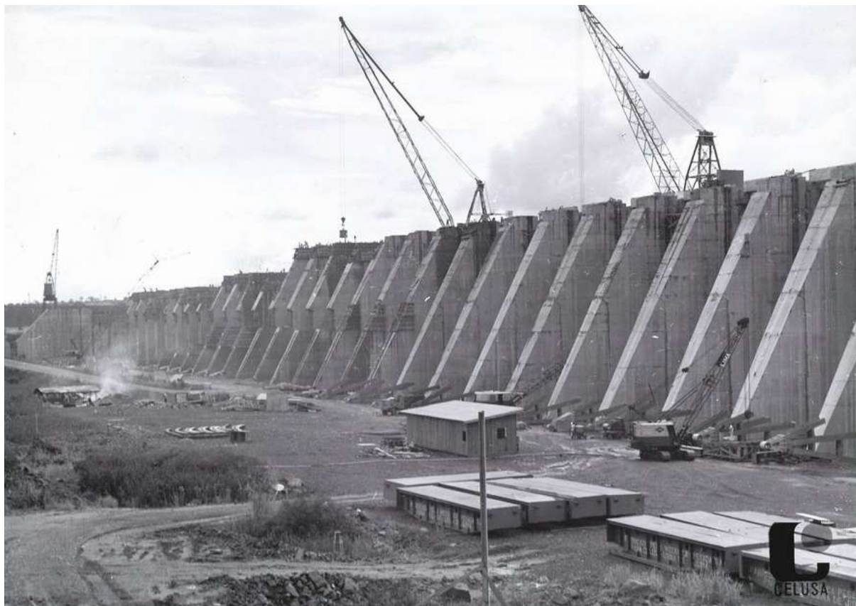
CONSTRUÇÃO HIDRELÉTRICA DE JUPIÁ.
