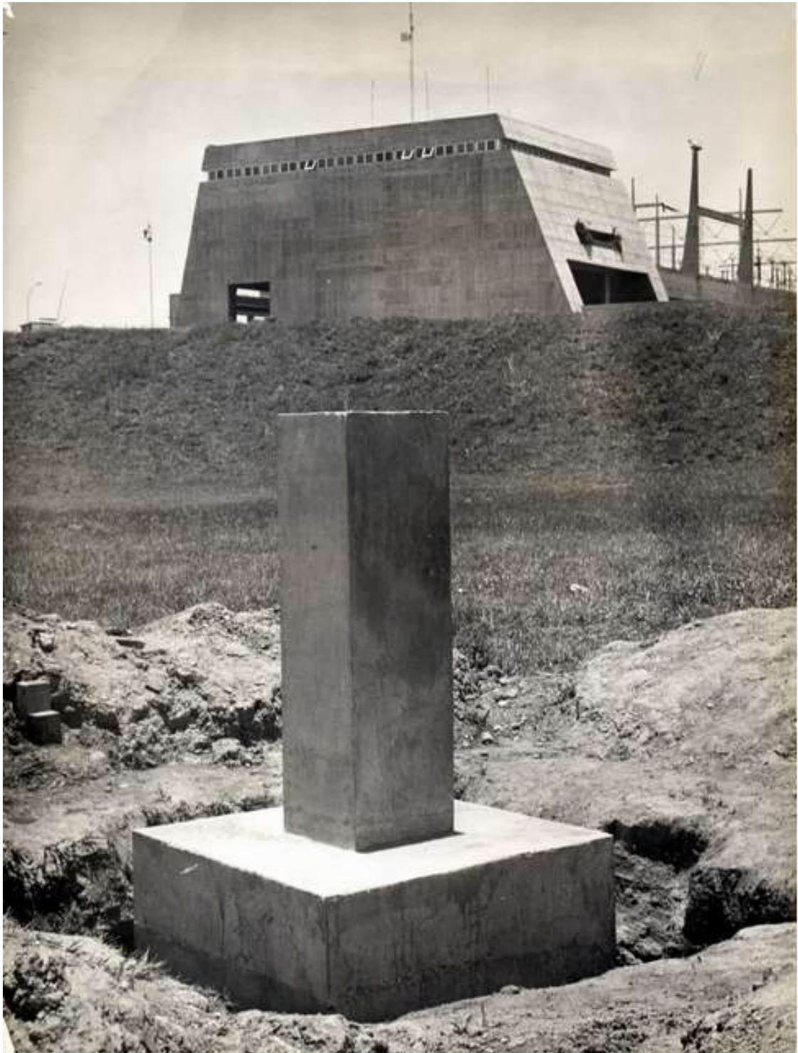
Pedra fundamental Complexo Hidrelétrico Urubupungá.
