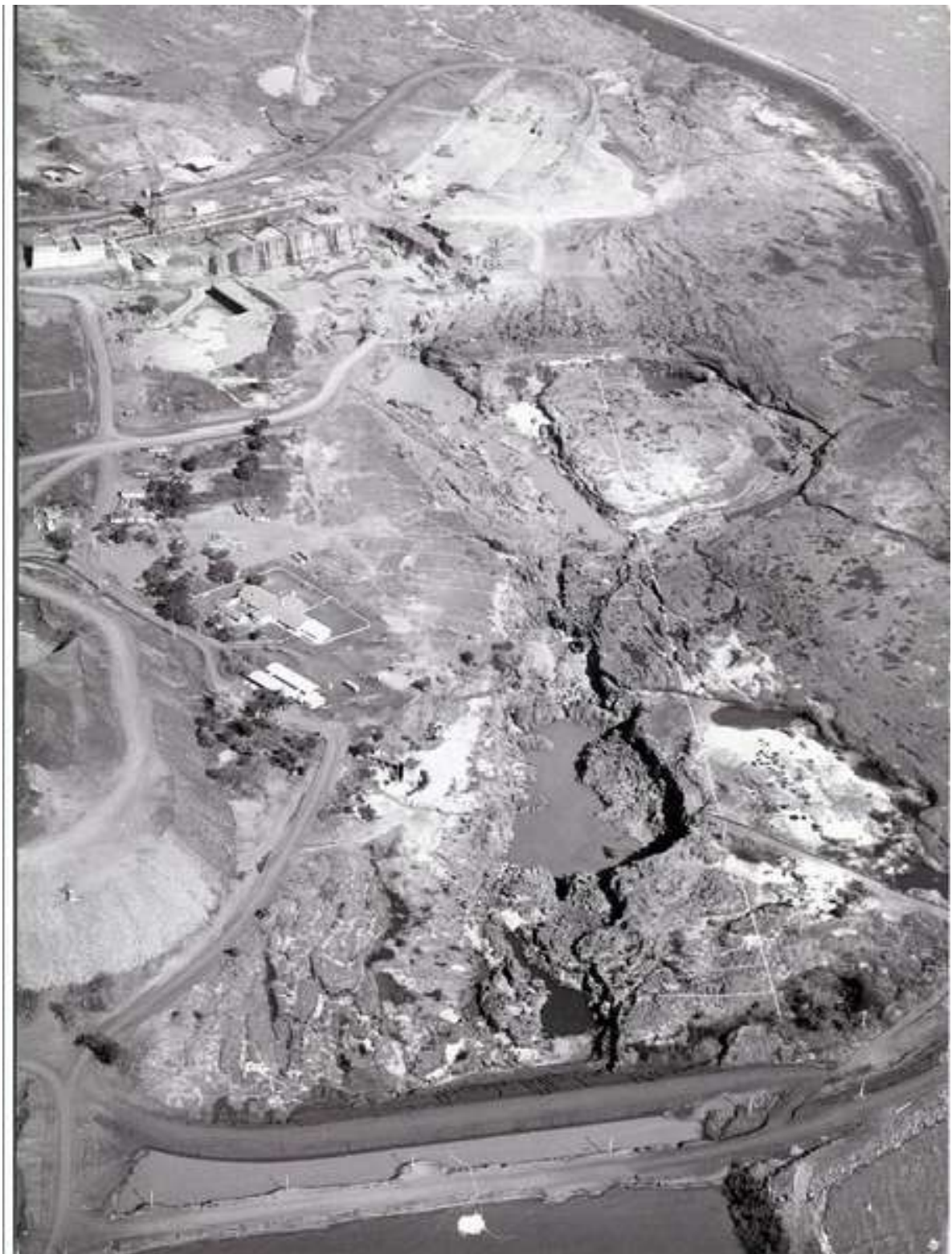
Local de construção da ensecadeira em Jupia
