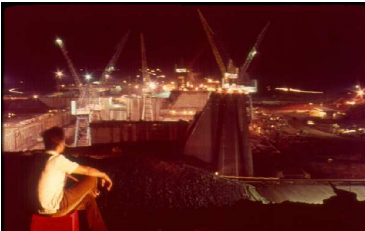
Construção hidrelétrica Ilha Solteira. Complexo de Urubupungá.
