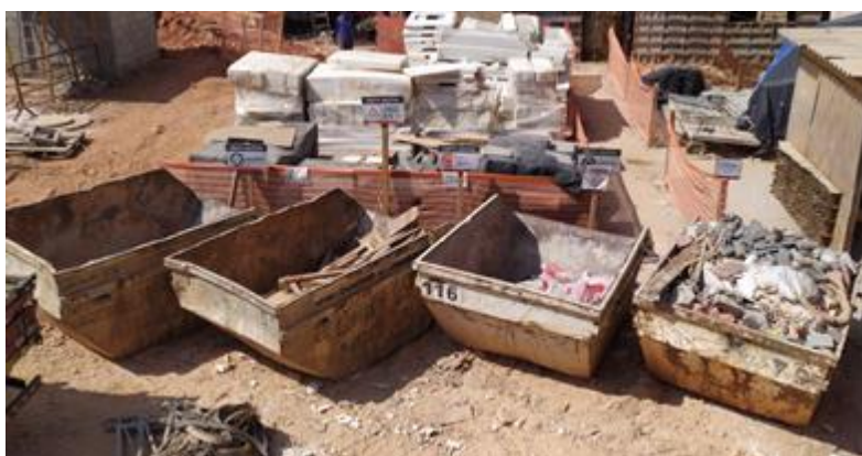
Figura 4 – Caçambas separadas por classe de resíduo em local de fácil acesso aos transportadores.
